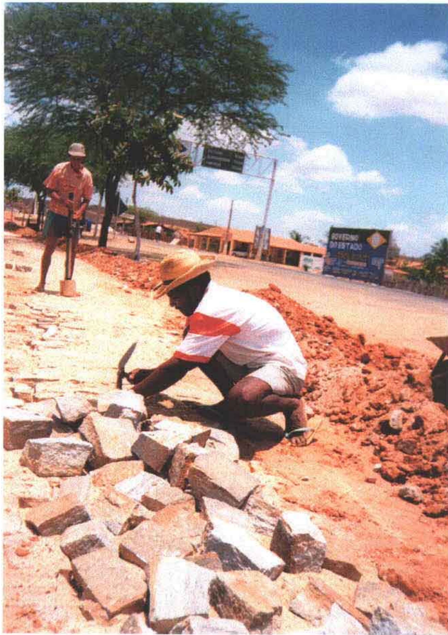
Foto 11 – Recuperação de pavimentação em dos trechos.
