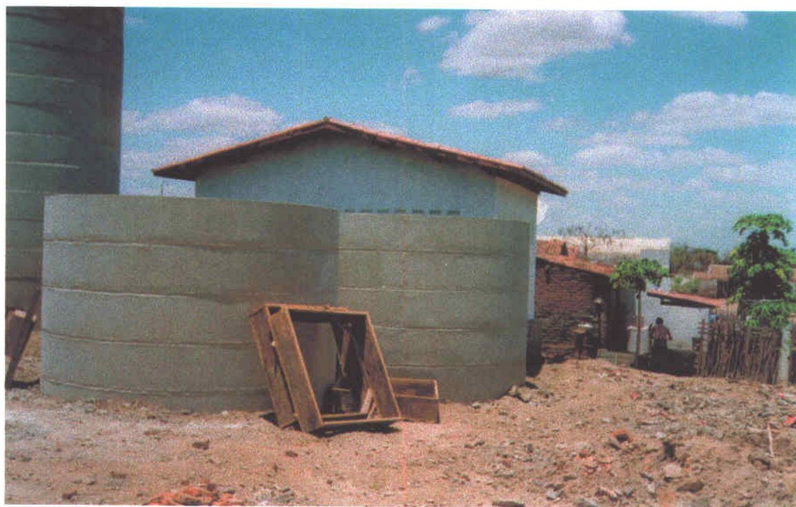
Foto 25 – Estação elevatória EE1 – casa de bombas e reservatório 80 m 3 . Na ETA.
