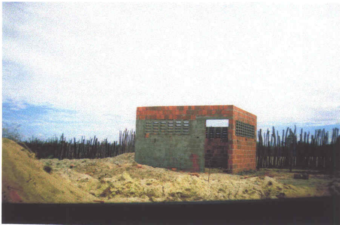
Foto 26 – Casa de bombas em construção da estação elevatória EE-2.
