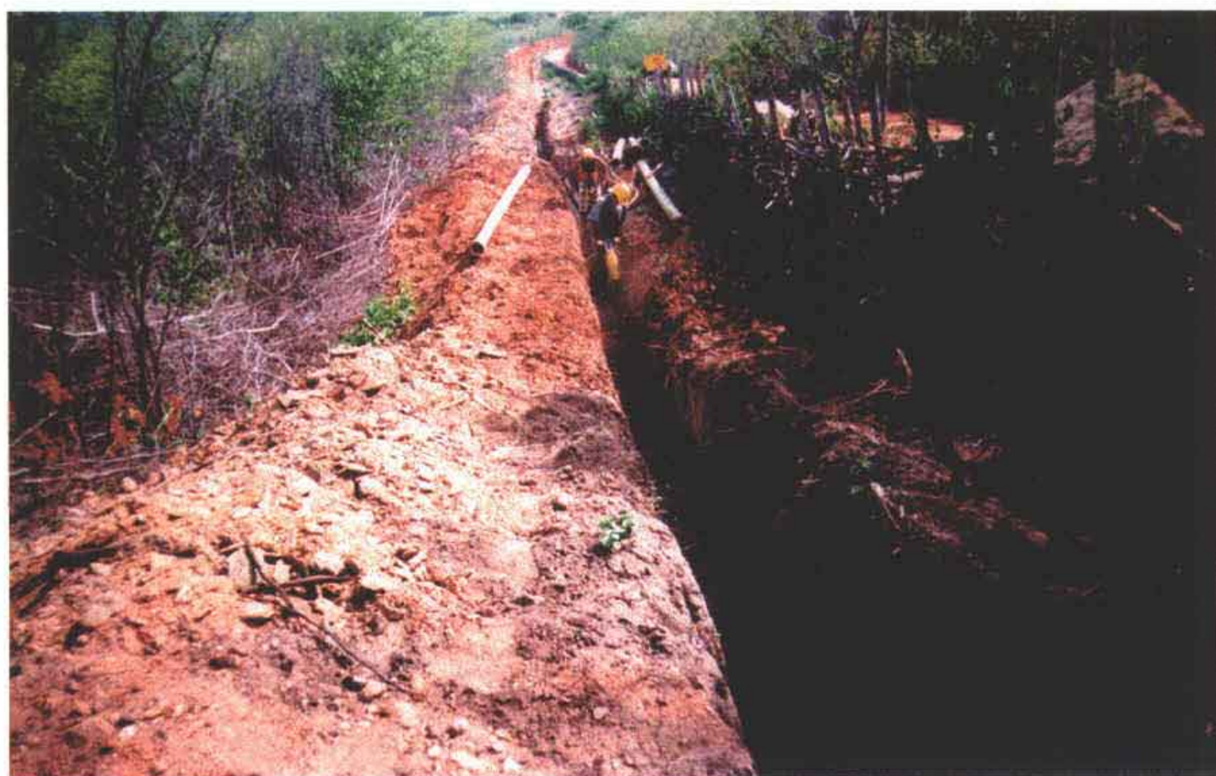
Foto 02 – Escavação em rocha, branda com uso do equipamento pneumático.
