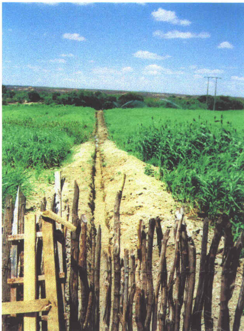
Foto 18 – Escavação da vala da estação de tratamento (ETA) até o local da captação no Rio Banabuiú.
