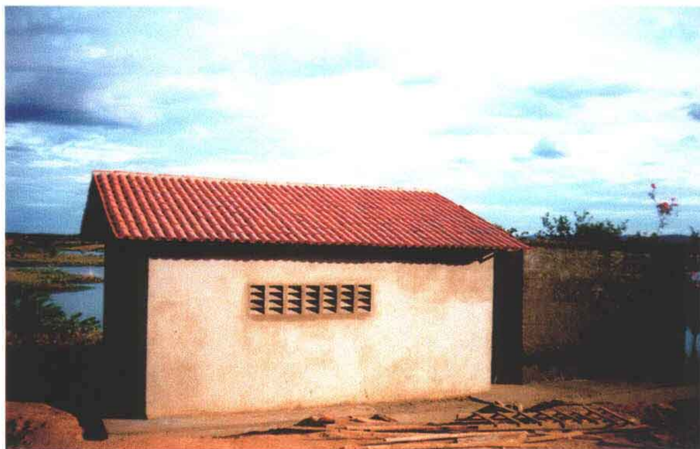
Foto 12 – Estação elevatória EE-2 em fase de conclusão.
