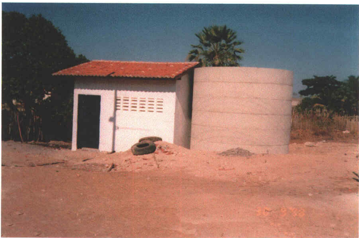
Foto 35 – Estação elevatória EE-4 – Casa de bombas e reservatório de 32 m 3 .
