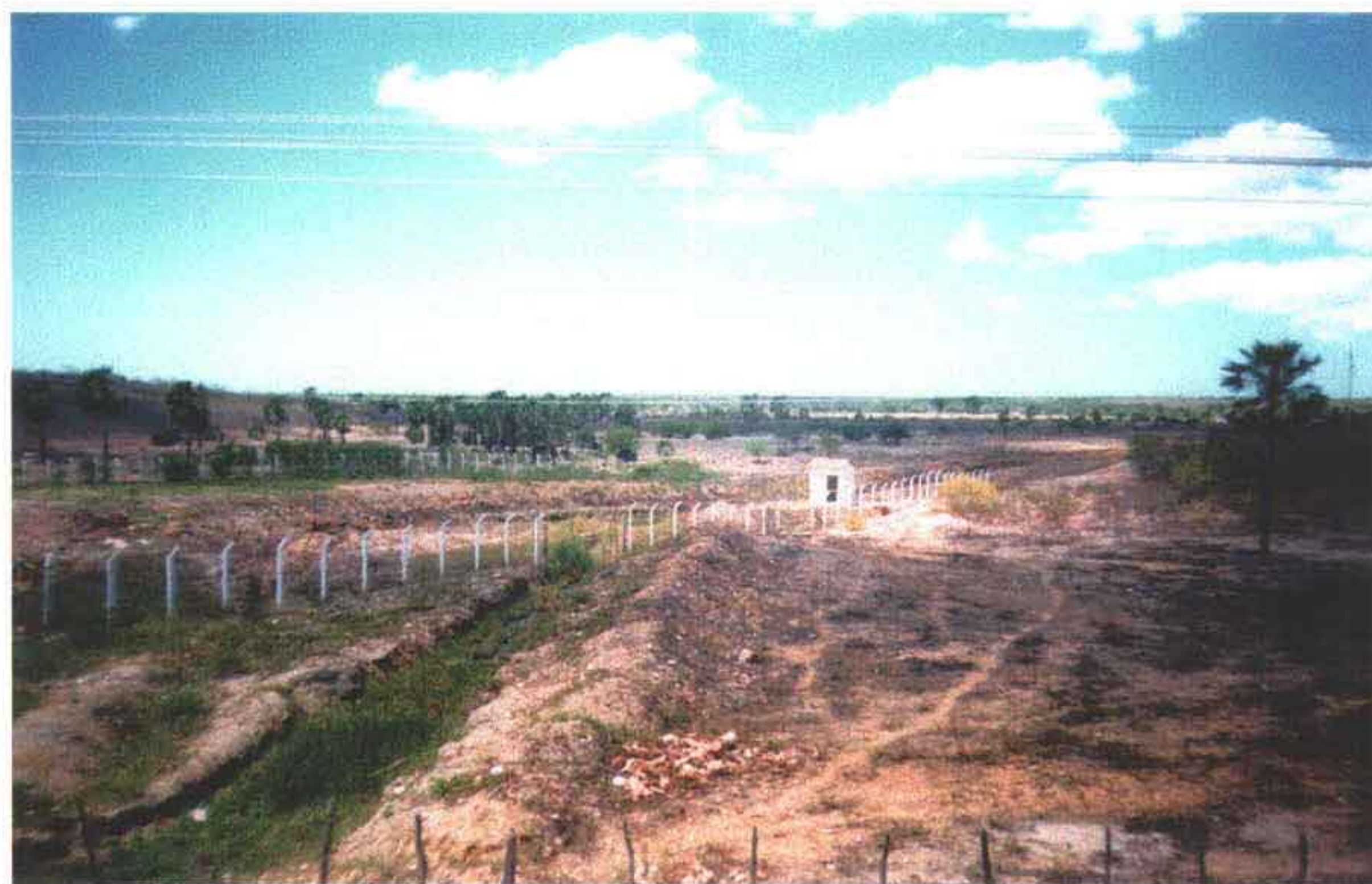
Foto 18 – Vista do canal do trabalhador e casa de comando das bombas na captação.
