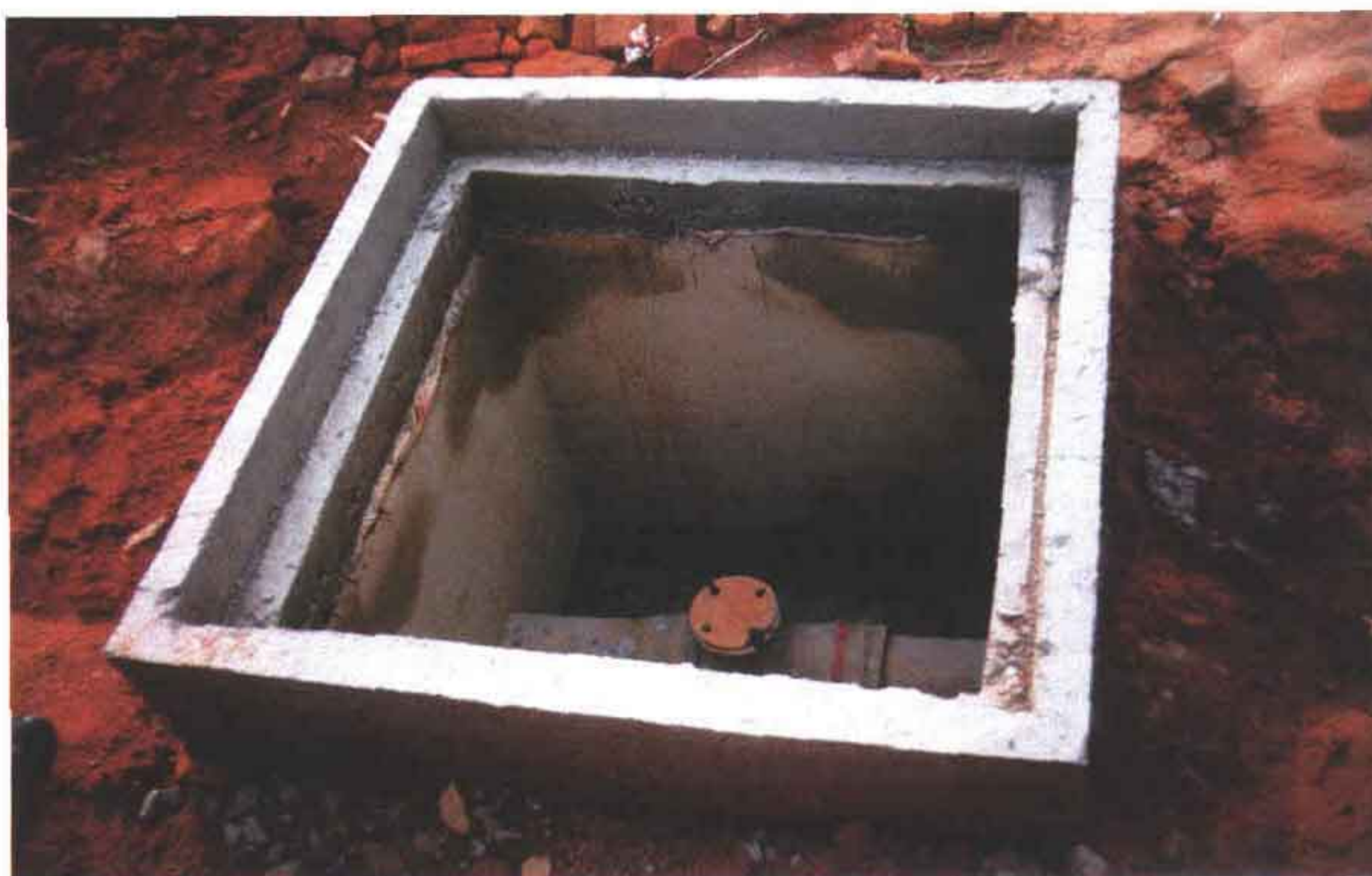
Foto 04 – Detalhe construtivo da caixa para ventosa.
