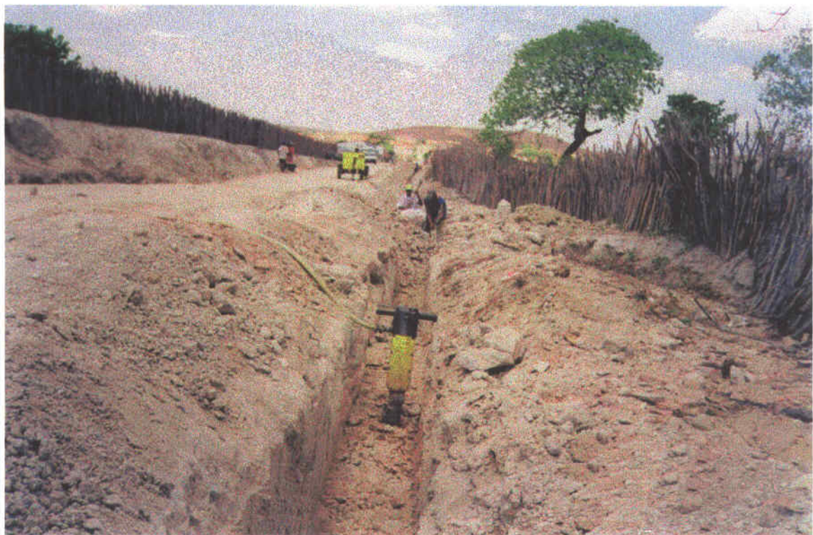
Foto 06 – Vala assentamento dos tubos RPVC e reaterro.
