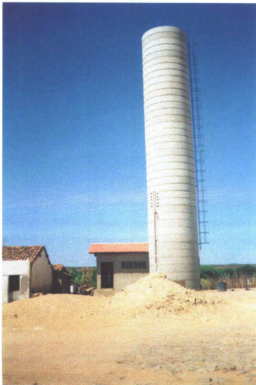
Foto 23 – Casa de bombas da estação elevatória EE-1 e reservatório elevado de 80 m 3 . Na ETA.
