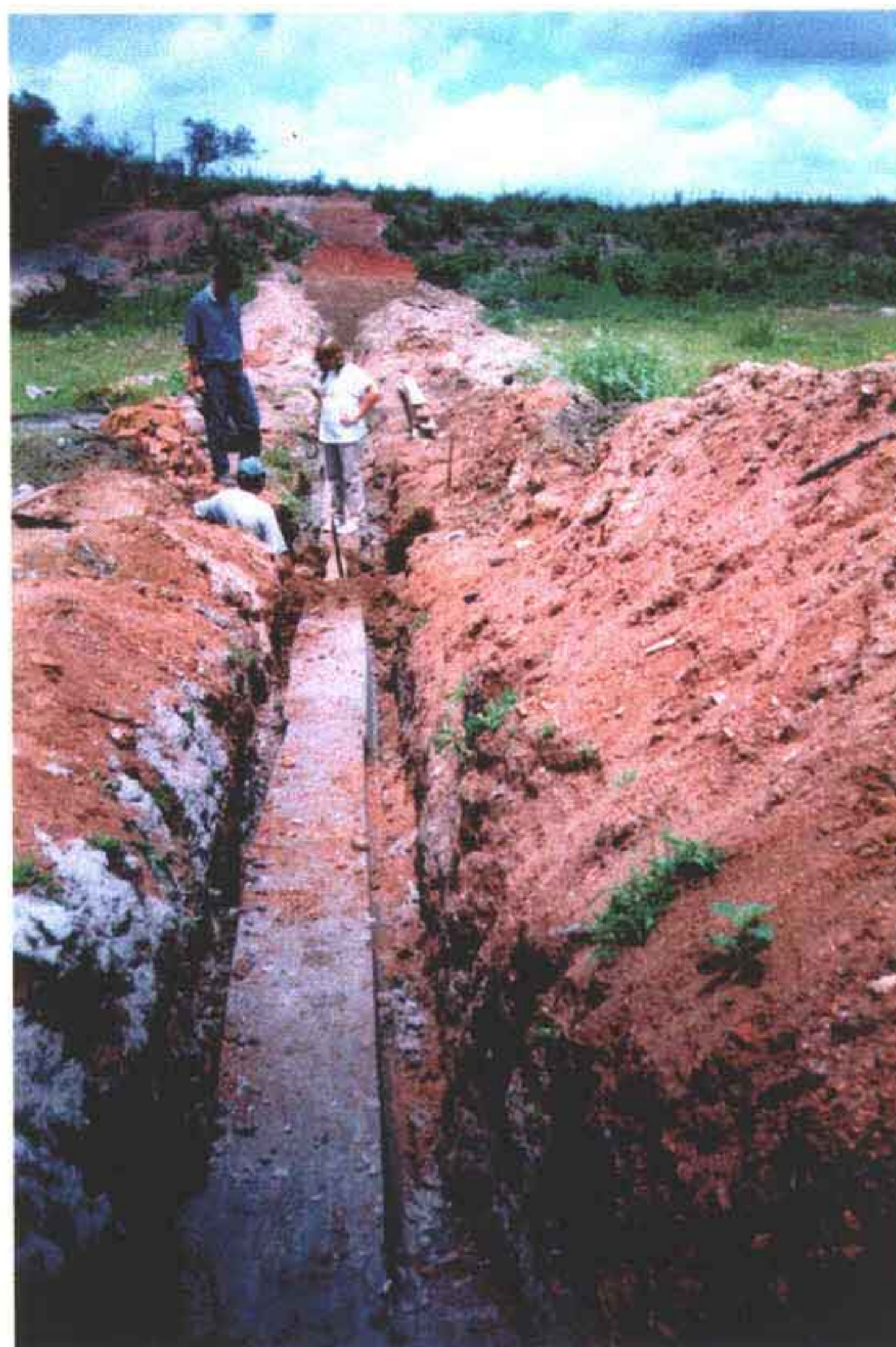
Foto 05 – Envolvimento dos tubos no trecho de área inundável pelas águas do açude São José.
