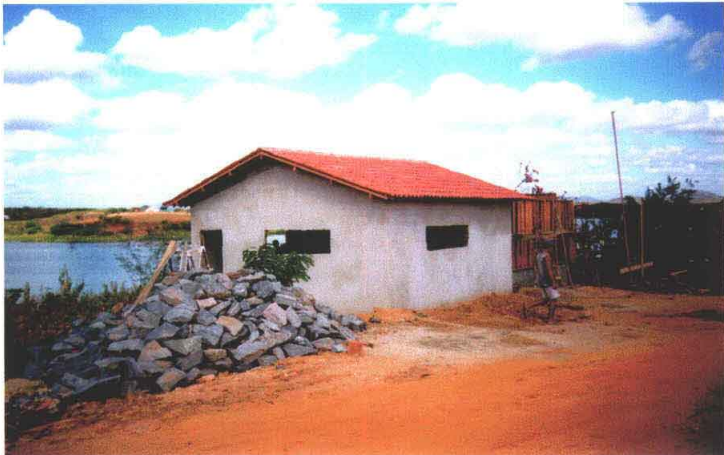
Foto 11 – Estação elevatória EE-2 – Casa de Bombas e reservatório de 50 m 3 em construção.
