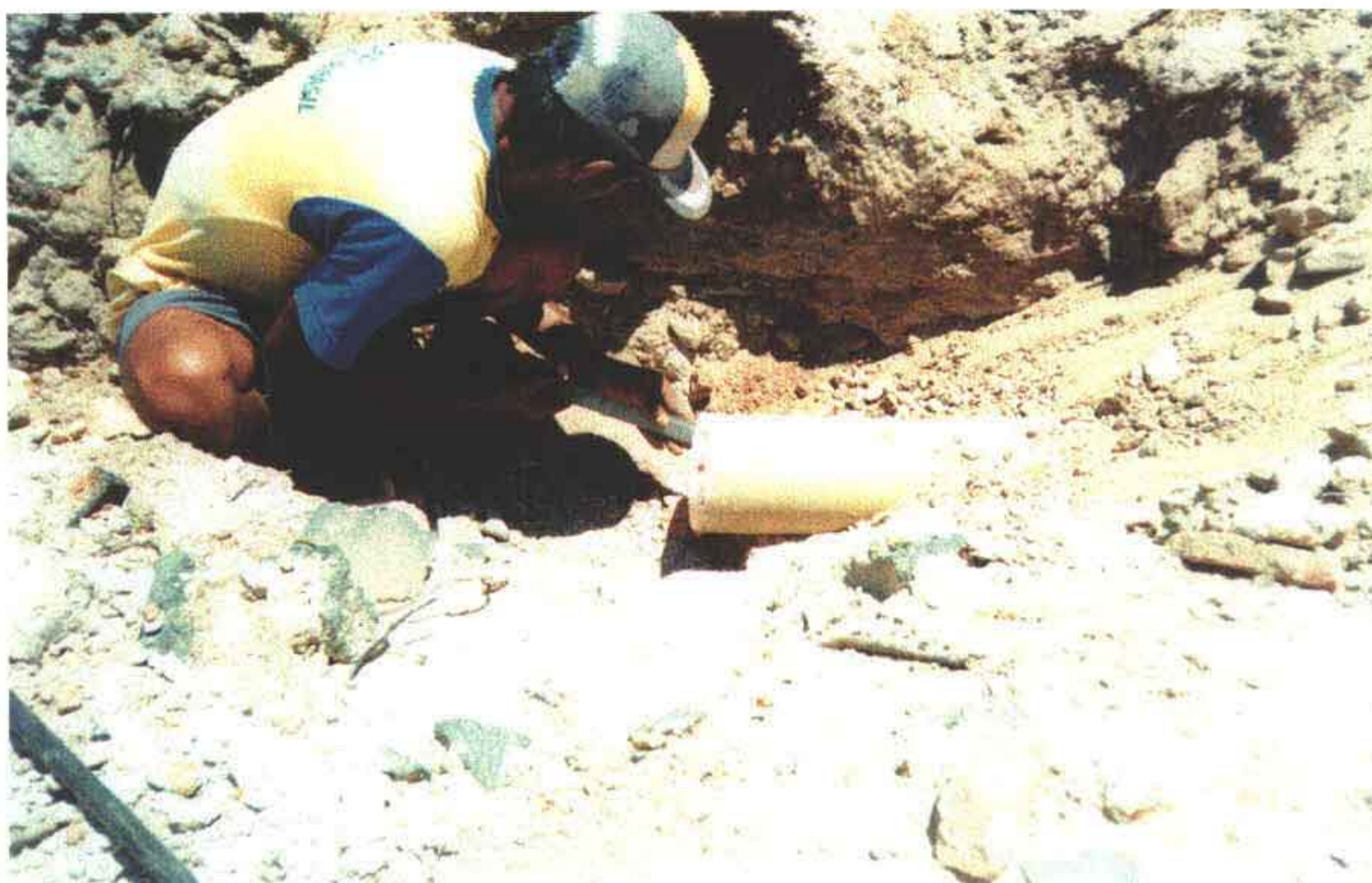
Foto 12 – Corte do tubo e execução do chanfro.
