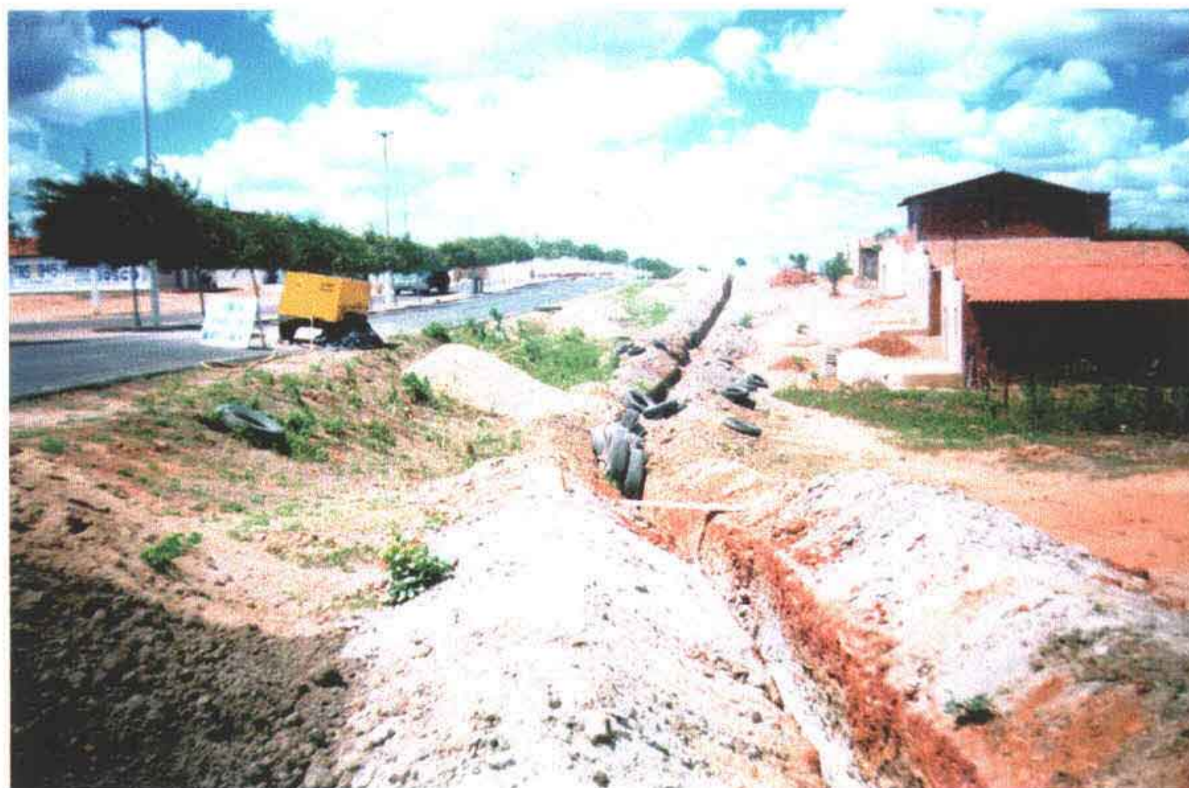
Foto 06 – Escavação em rocha na entrada da cidade de Piquet Carneiro.
