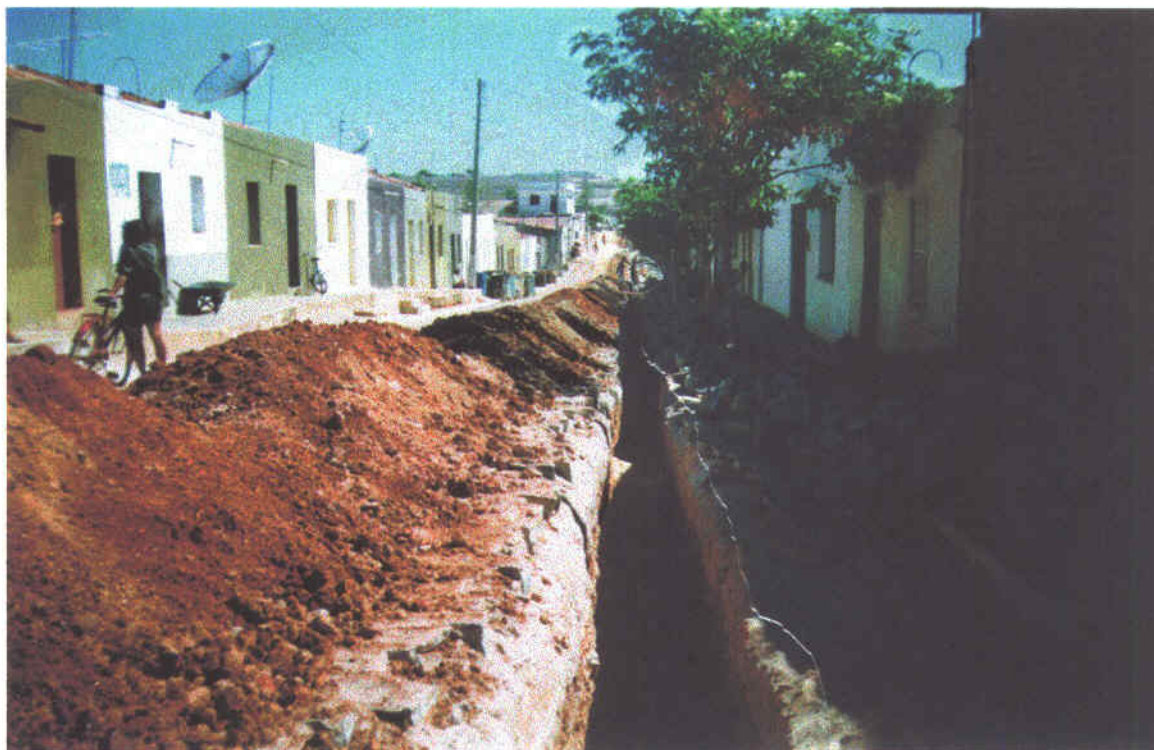
Foto 10 – Escavação no centro da cidade de Ibicuitinga.
