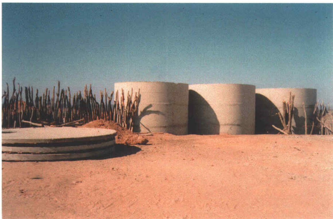
Foto 39 – Reservatório apoiado de 80 m 3 em fase de conclusão.
