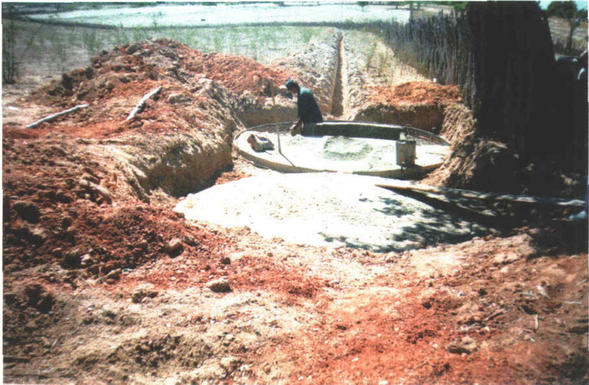
Foto 36 – Laje de fundo do reservatório apoiado de 80 m 3 .
