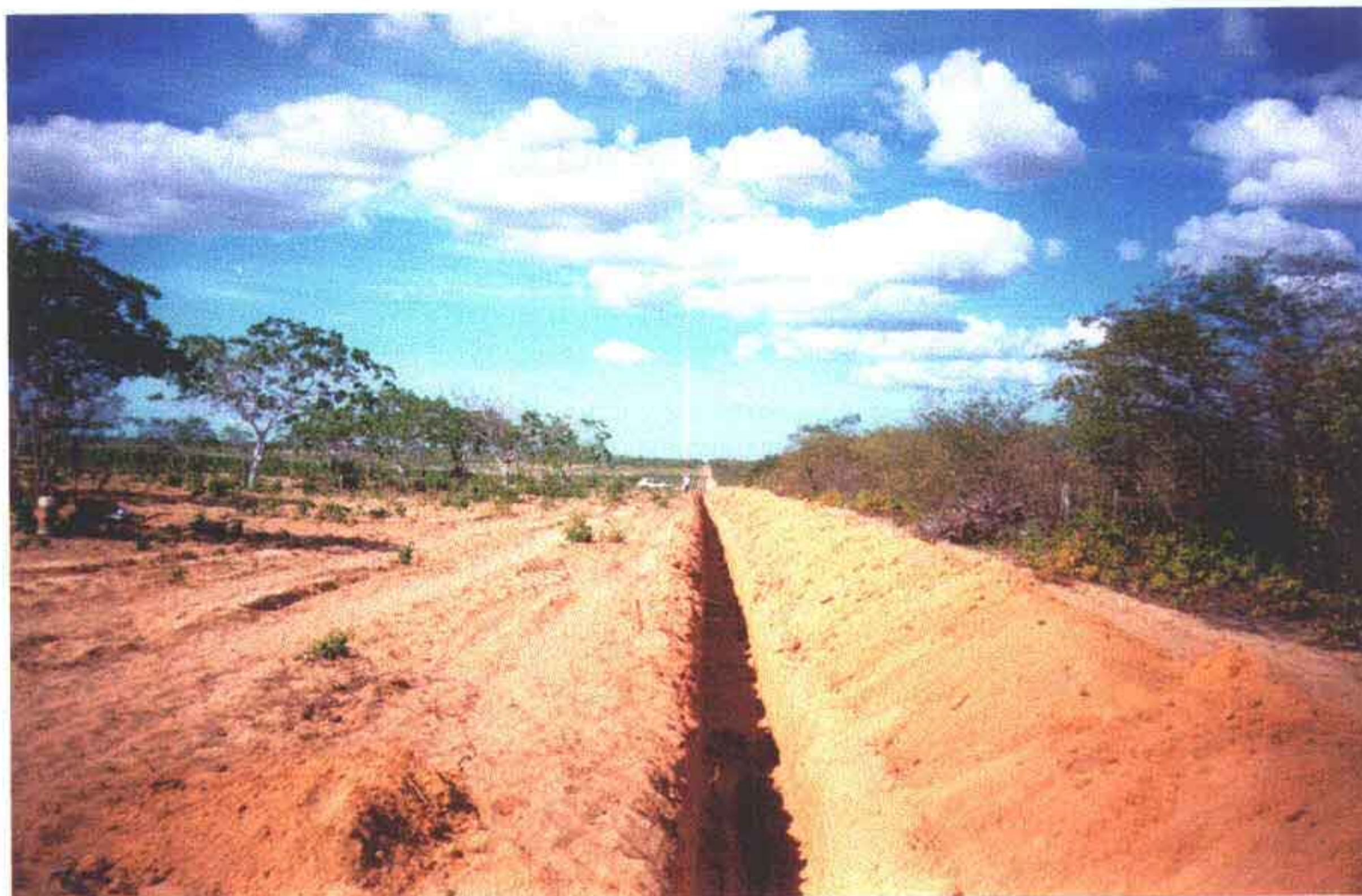
Foto 09 – Escavação da vala no local da 2ª torre Piezometrica.
