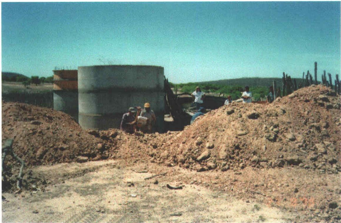
Foto 38 – Reservatório apoiado de 80 m 3 em execução.
