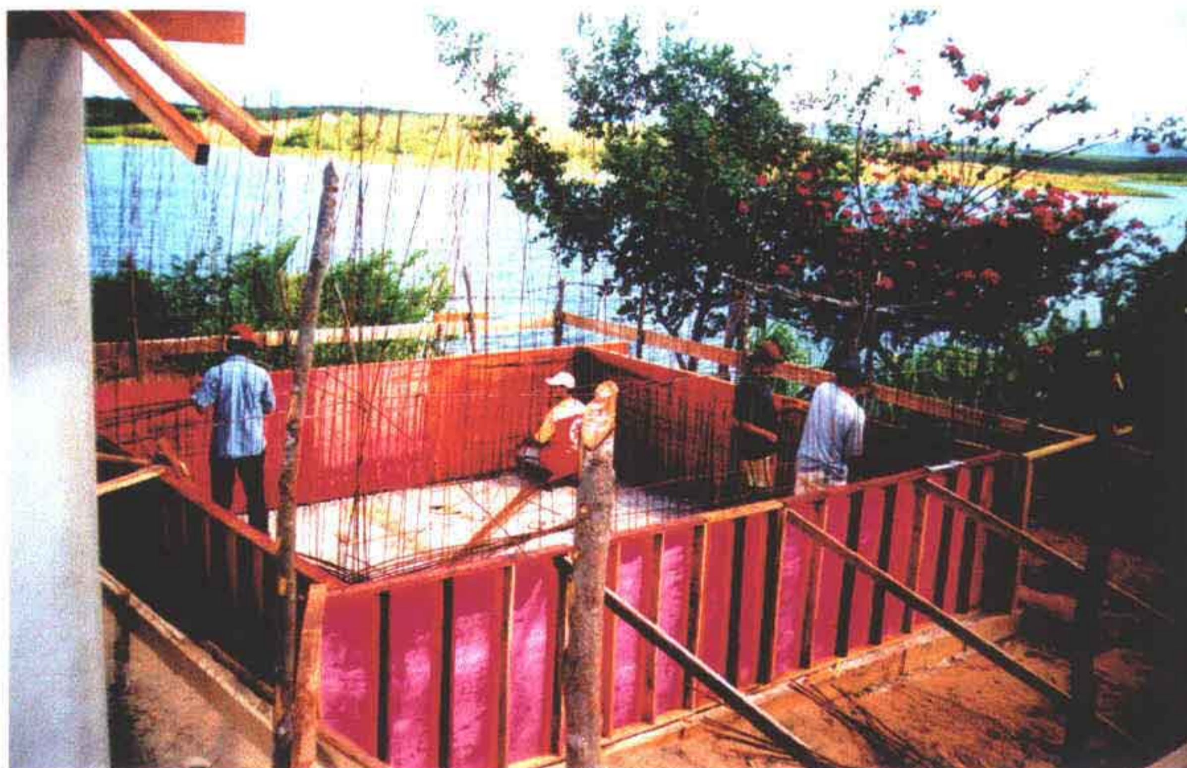
Foto 10 – Concretada a laje do fundo e iniciada as formas e ferragens das paredes do reservatório de 50 m 3 – estação elevatória EE-2.
