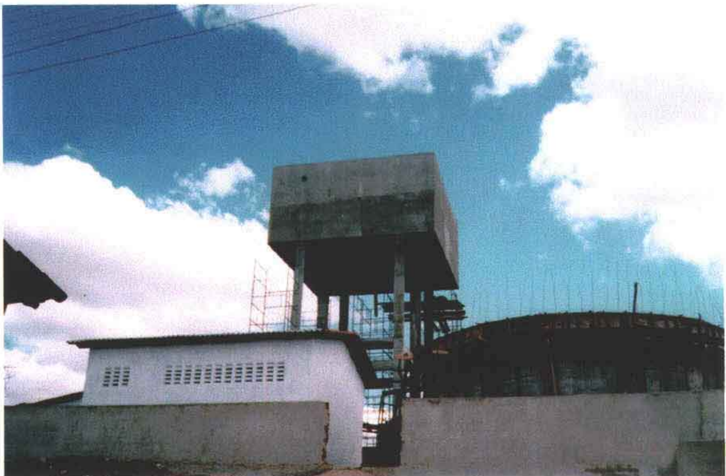
Foto 28 – Recuperação do reservatório elevado de 200 m 3 .
