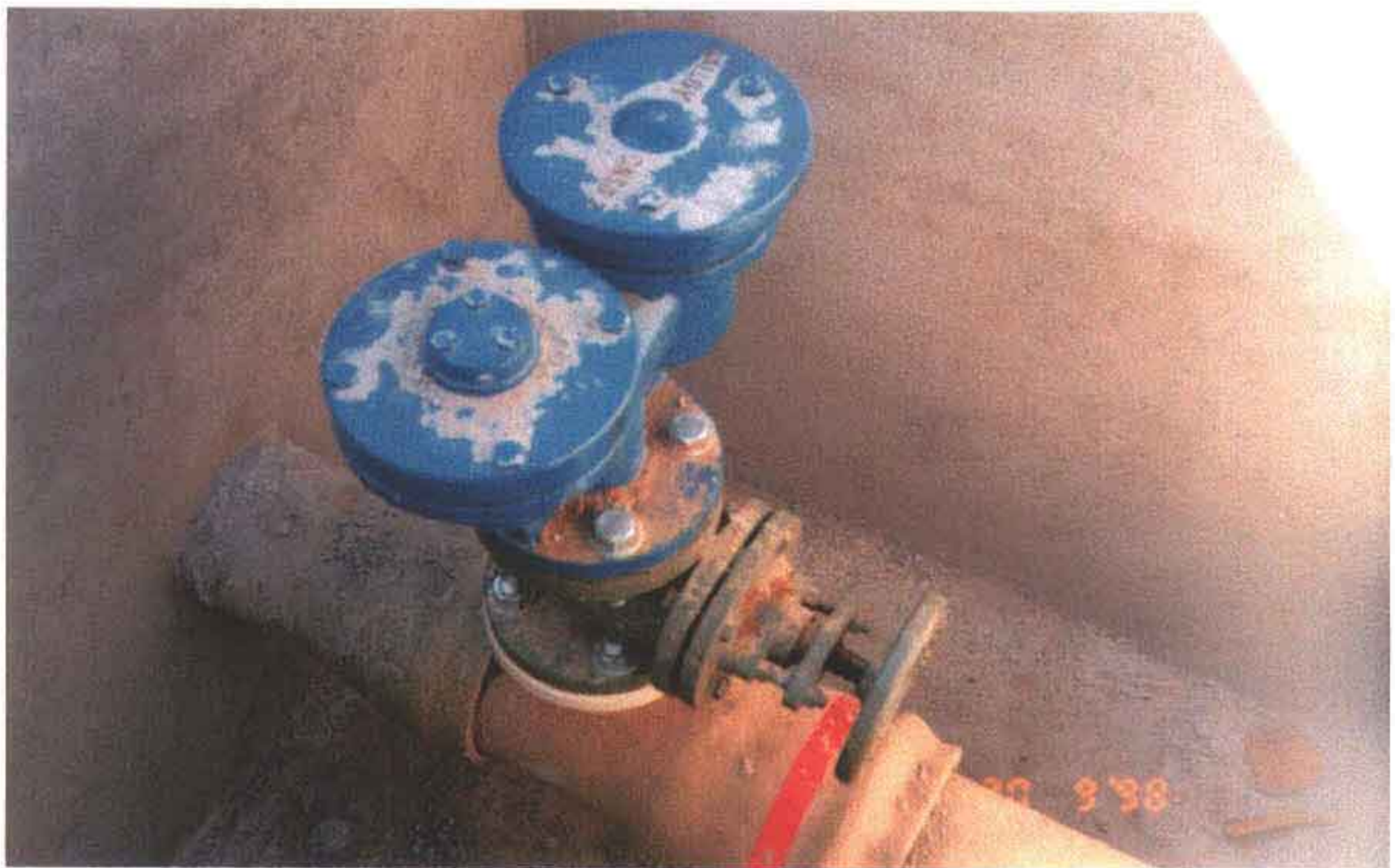
Foto 08 – Ventosa de tríplice função e registro de gaveta chato com flange e volante.
