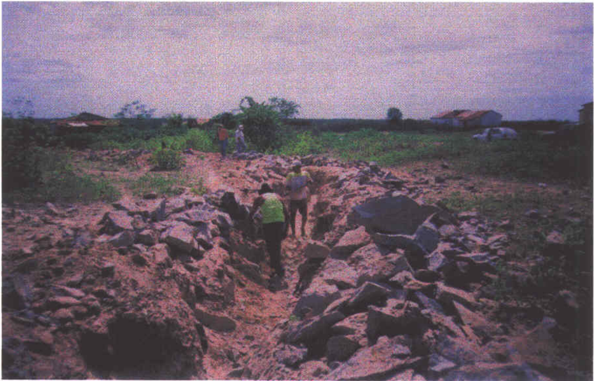
Foto 14 – Limpeza da vala após uso de explosivo.
