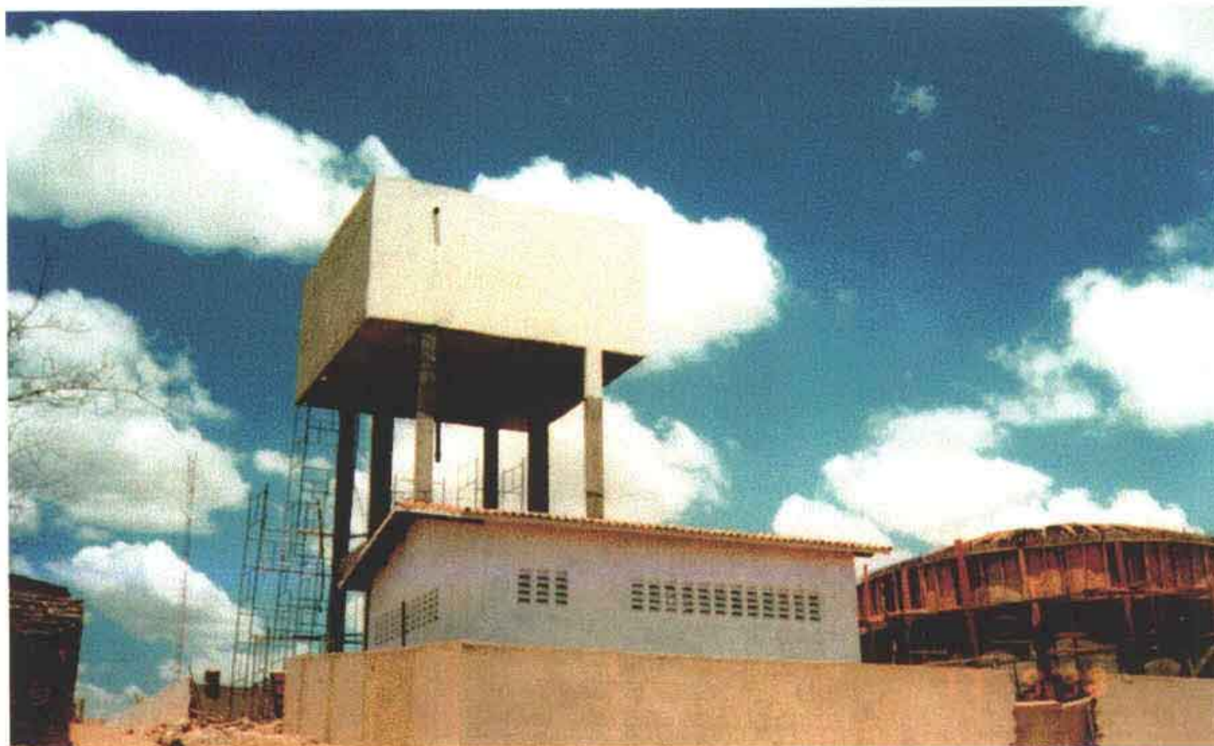
Foto 29 – Reservatório elevado de 200 m 3 ; Reservatório apoiado de 200 m 3 e casa de bombas.
