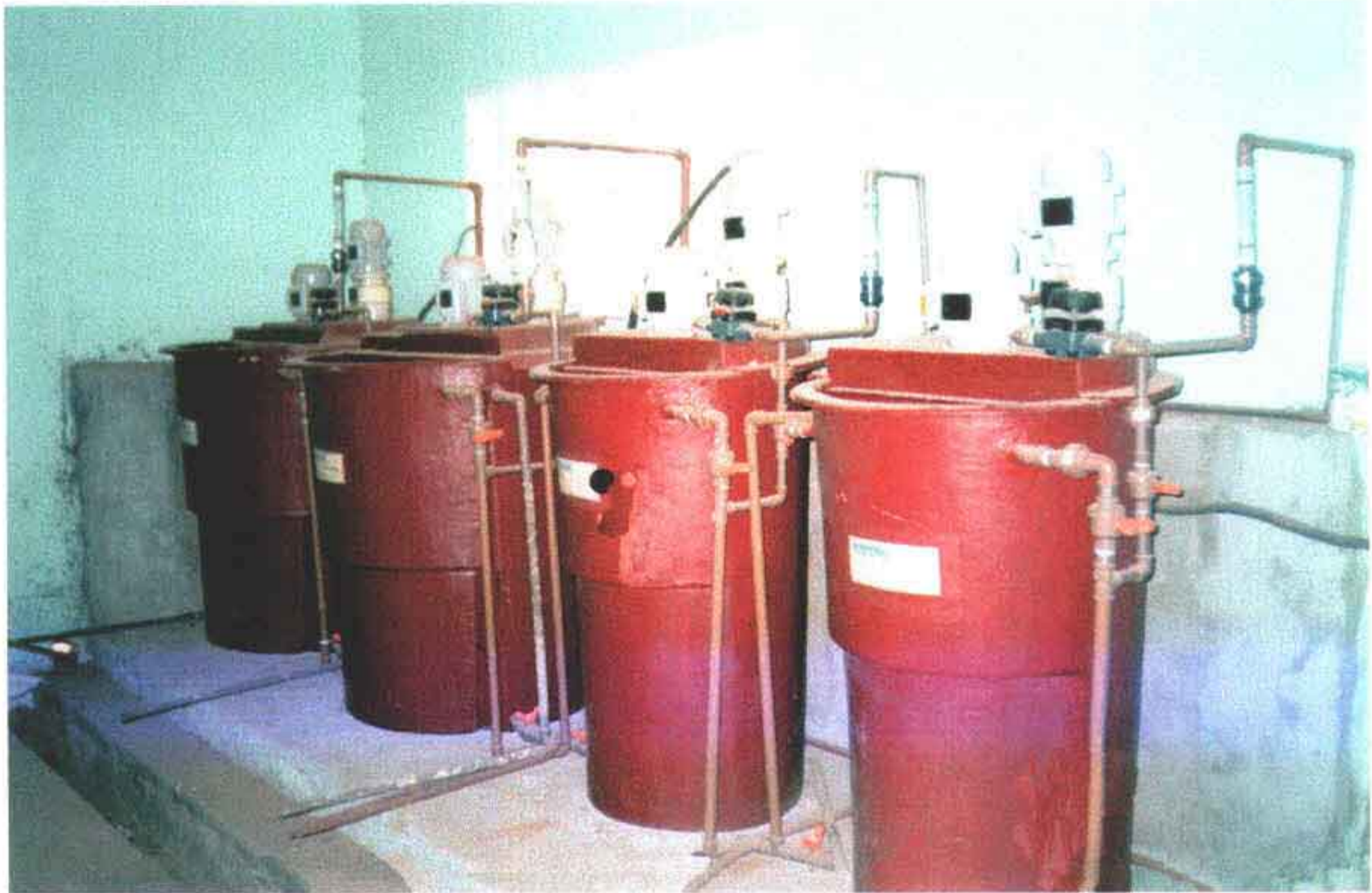
Foto 33 – Tanques desadores para sulfato de alumínio e cloro na casa de Química sendo instalados pela construtora responsável pelas obras da rede de distribuição.
