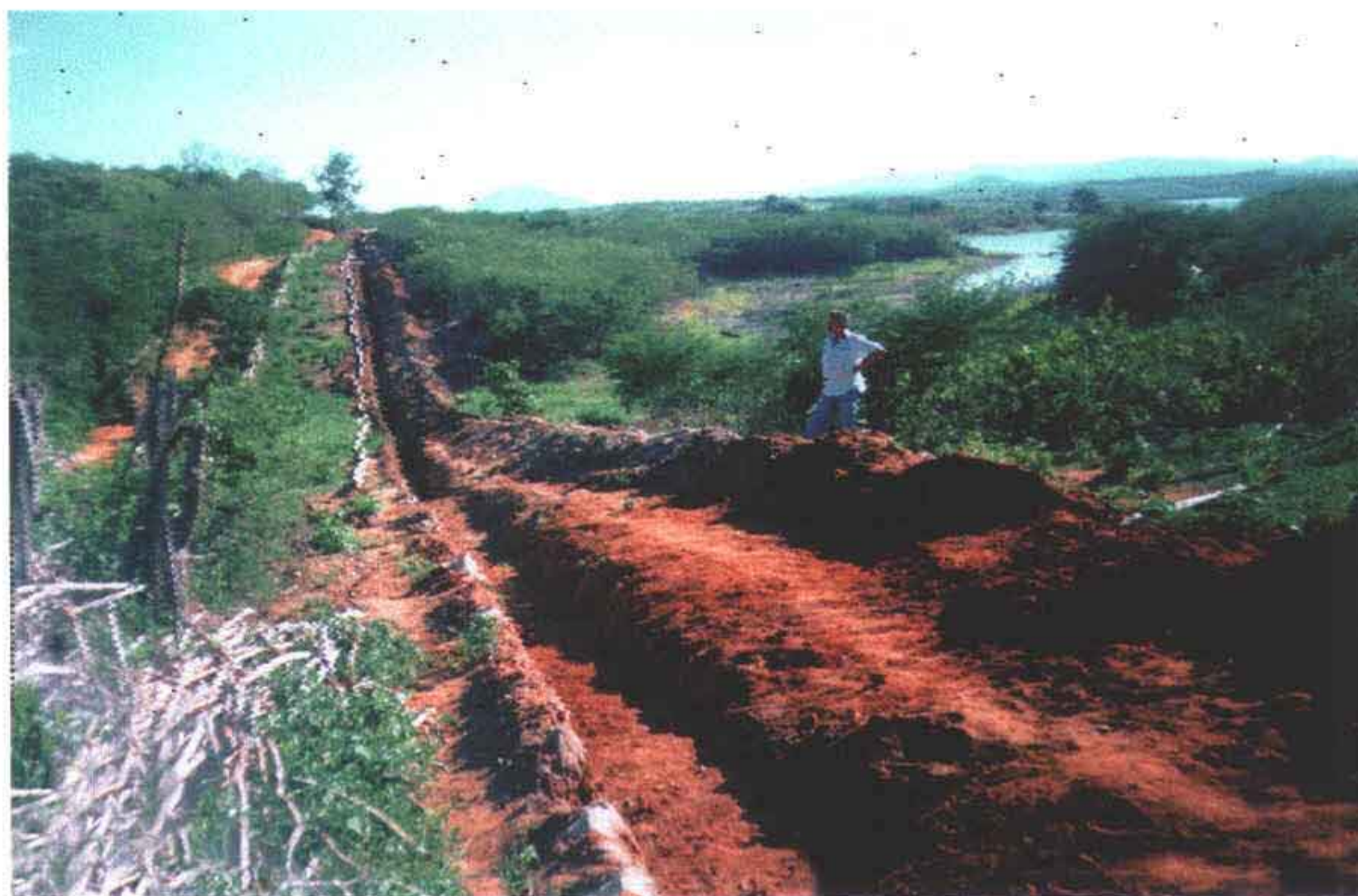
Foto 04 – Trecho com vala escavada e outro já sendo executado o reaterro.
