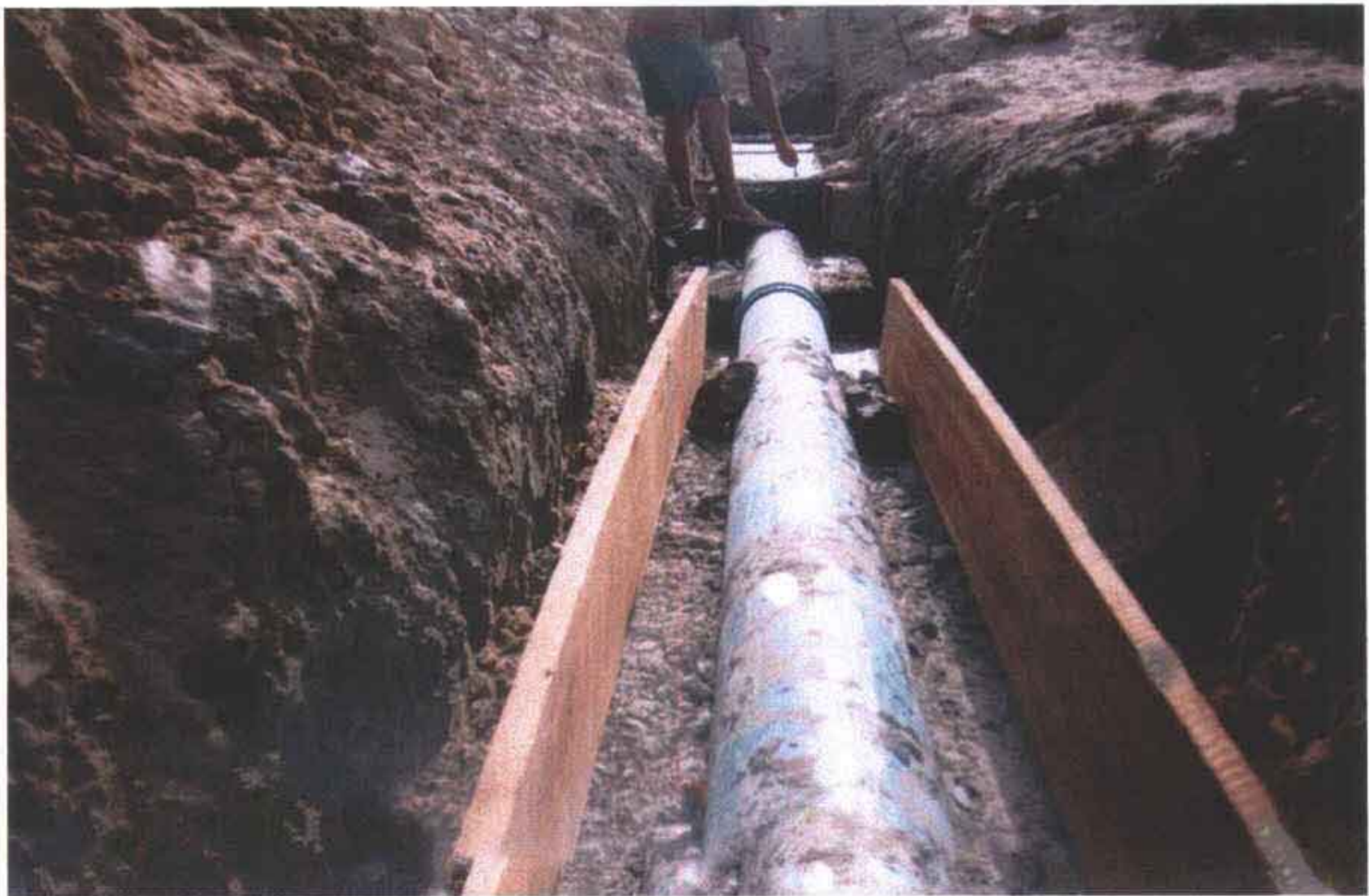
Foto 04 – Execução de envelopamento em trecho da adutora.
