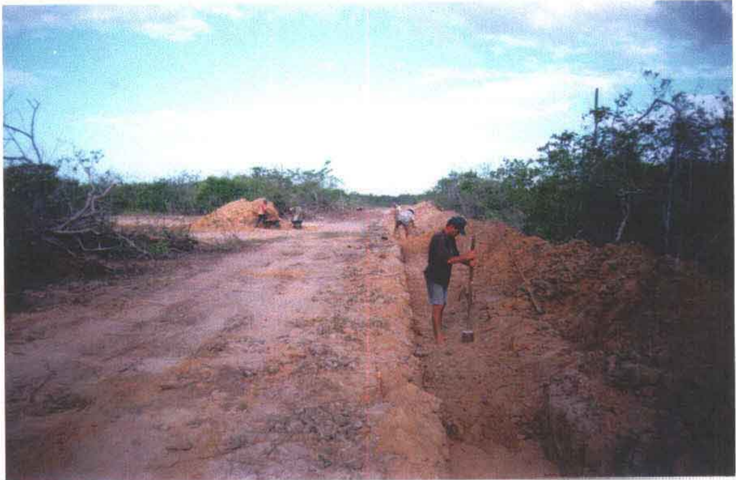
Foto 05 – Reaterro das valas em camadas.
