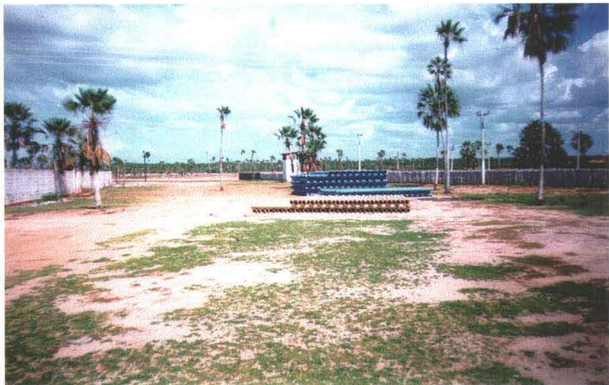
Foto 02 – Pátio para armazenamento dos tubos.
