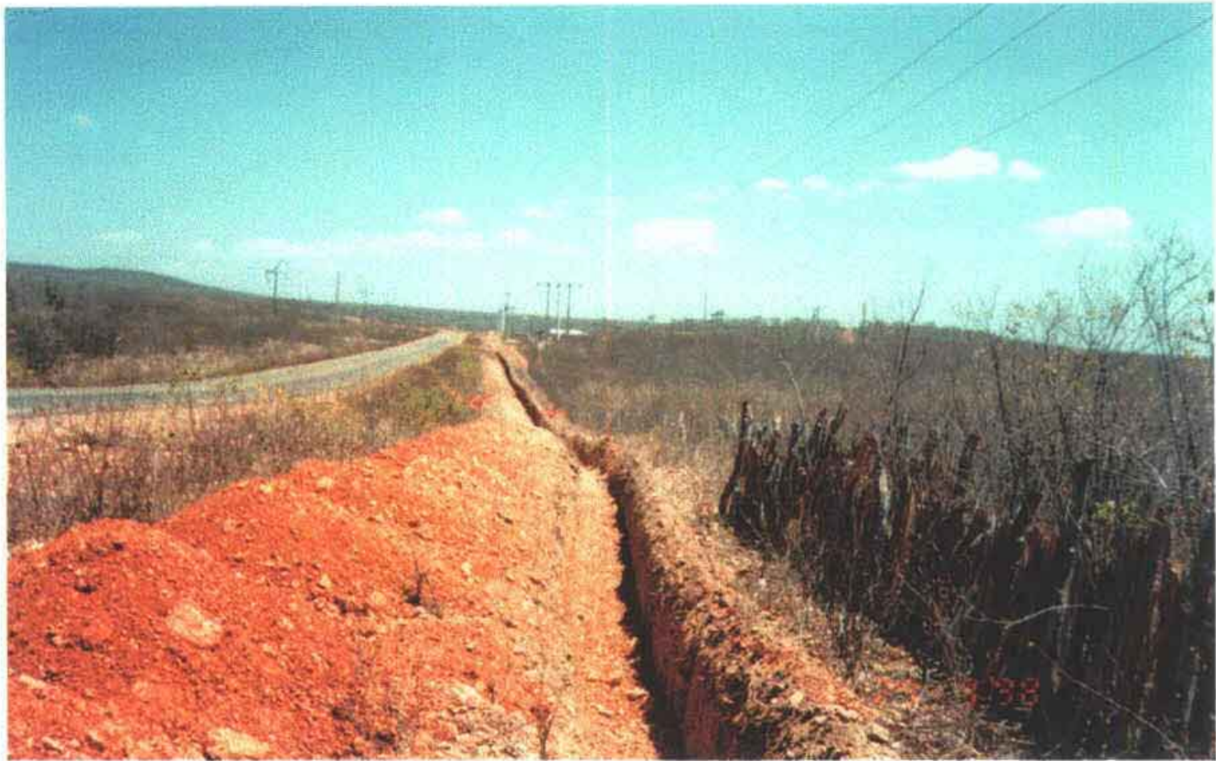
Foto 15 – Escavação de parte da vala na faixa de domínio da CE-123
