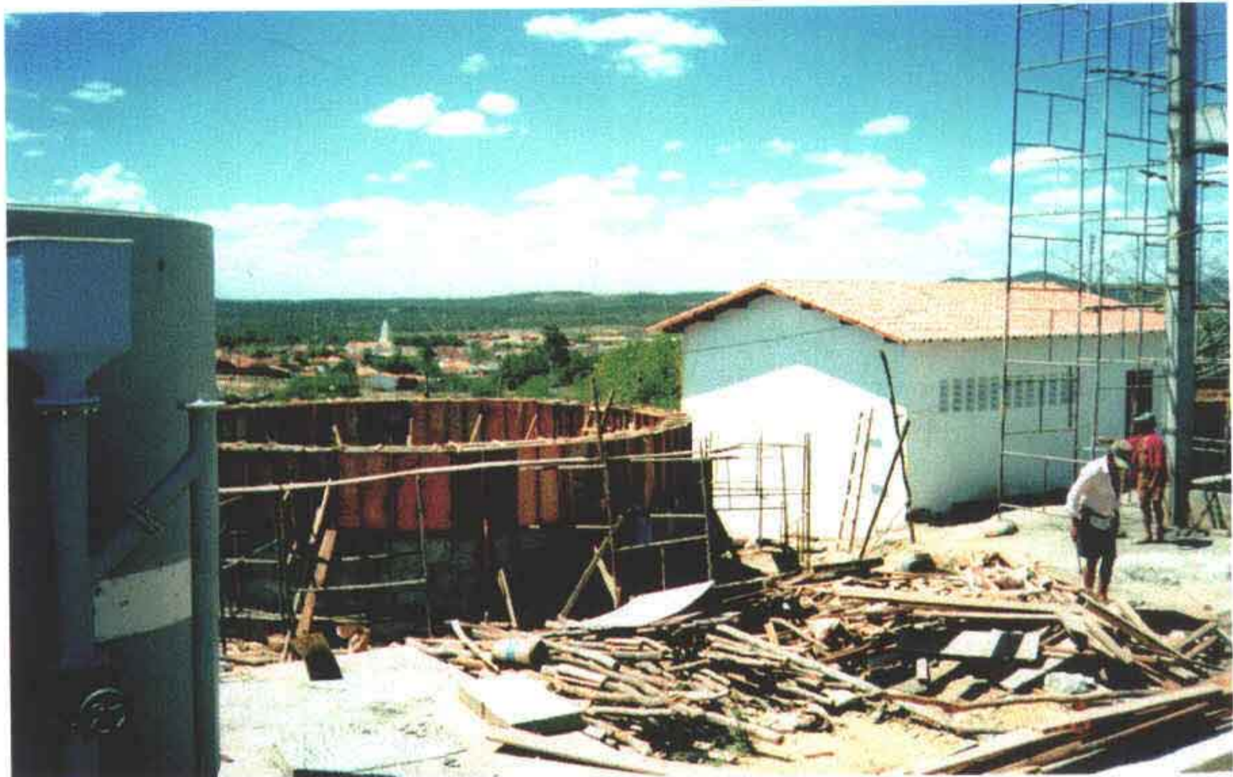
Foto 21 – Concretagem das paredes do reservatório apoiado 200 m 3 e vista parcial da casa de bombas.
