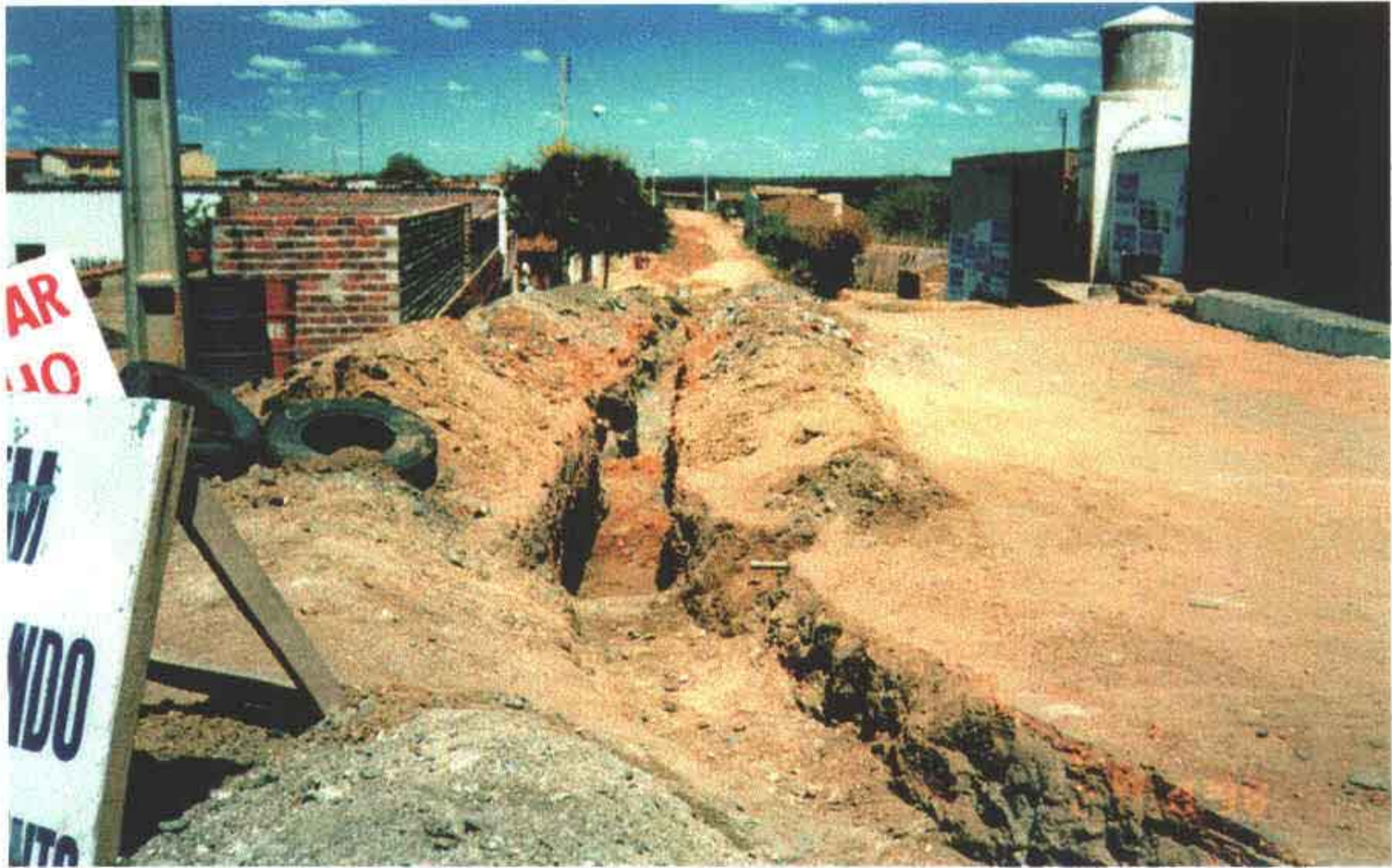
Foto 07 – Escavação em rocha no centro da cidade de Piquet Carneiro.
