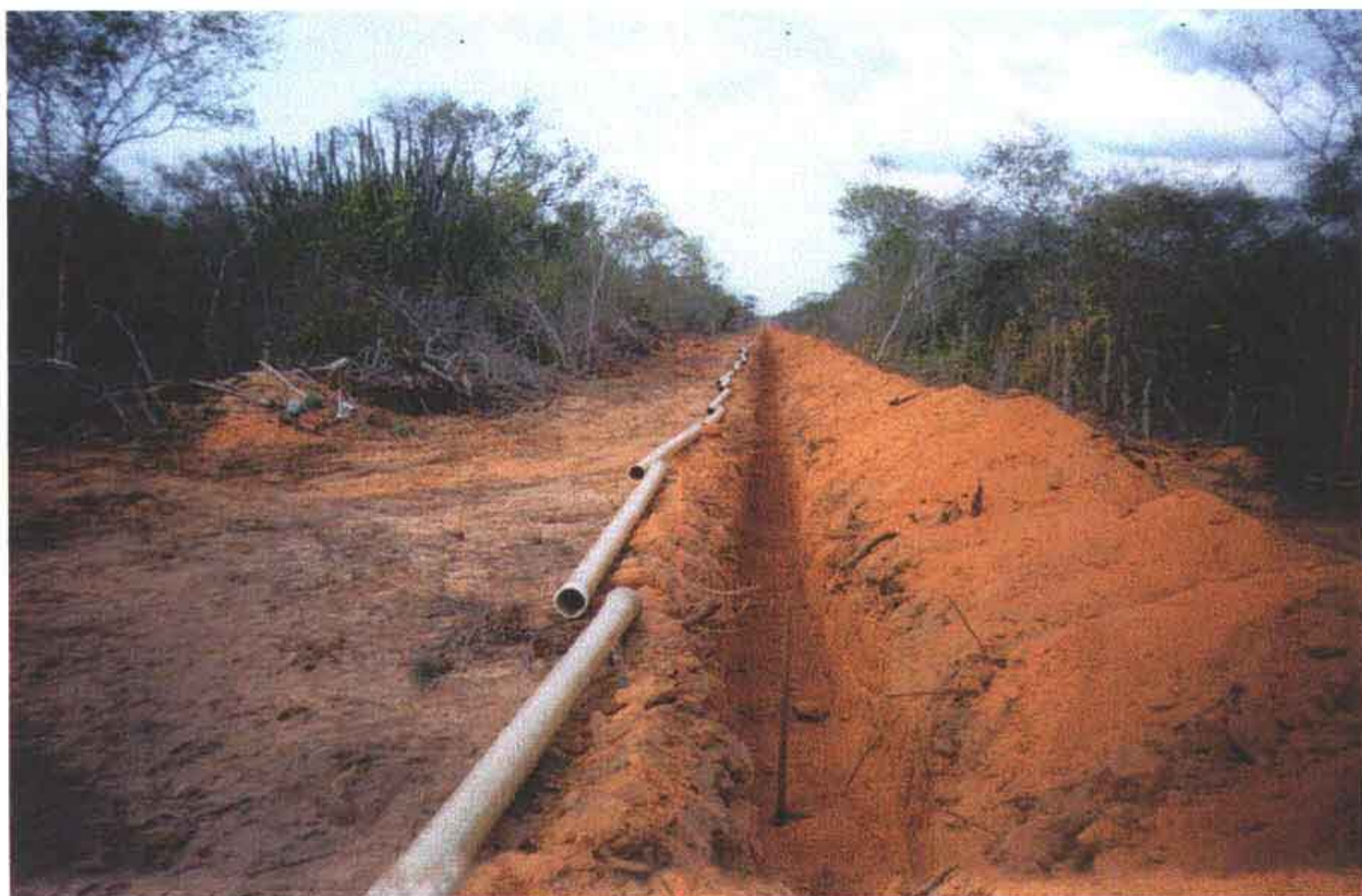
Foto 08 – Regularização do fundo da vala para assentamento dos tubos.
