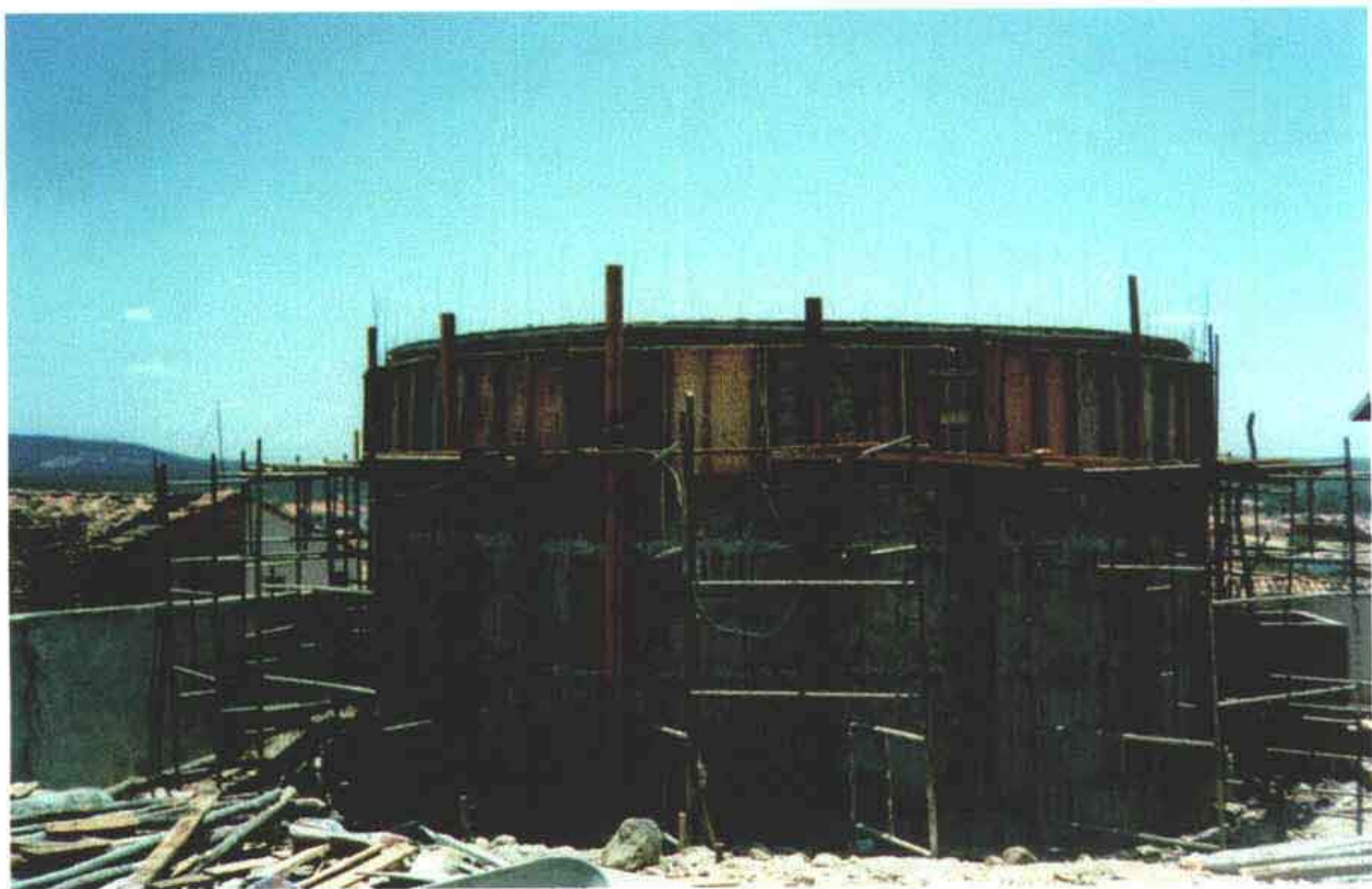
Foto 22 – Concretagem do reservatório apoiado de 200 m 3 .
