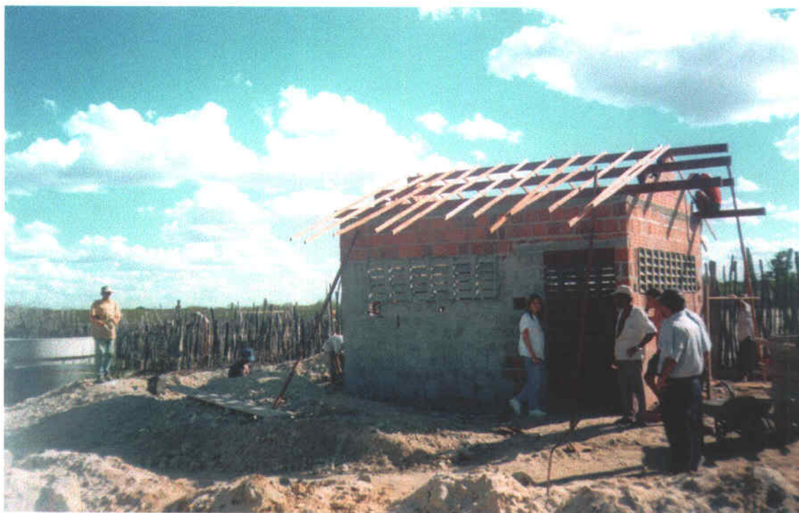
Foto 28 – Casa de bombas em construção da Estação elevatória EE-3.
