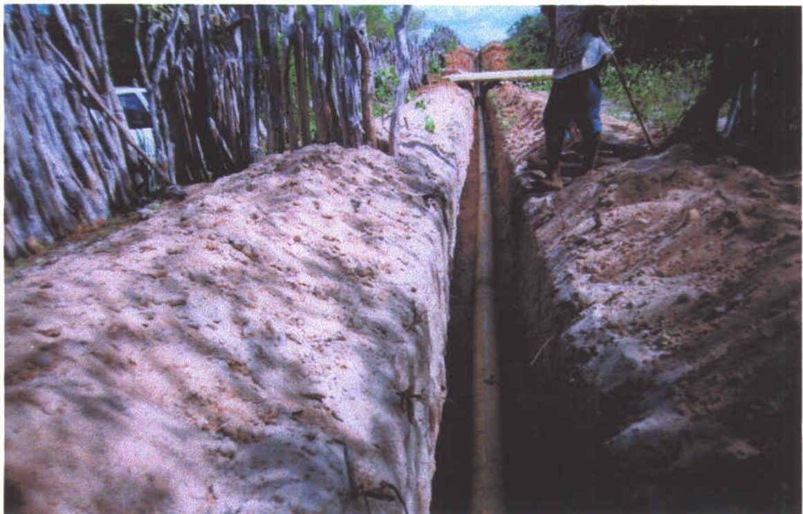
Foto 08 – Tubos assentados sobre berço de areia.
