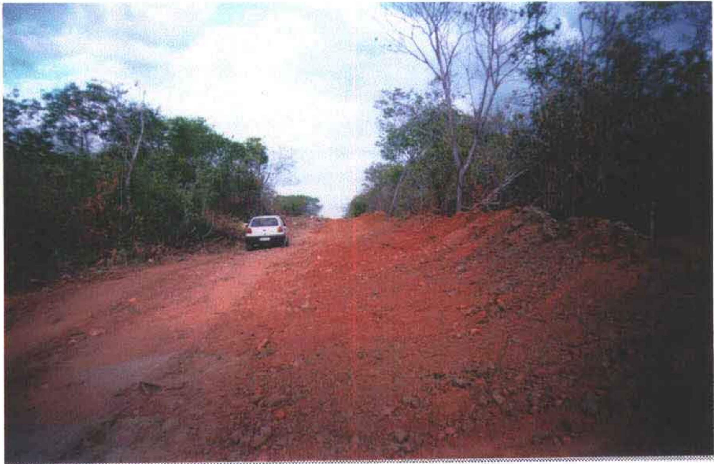
Foto 06 – Valas aterradas e caminho de serviço em um dos trechos da adutora.
