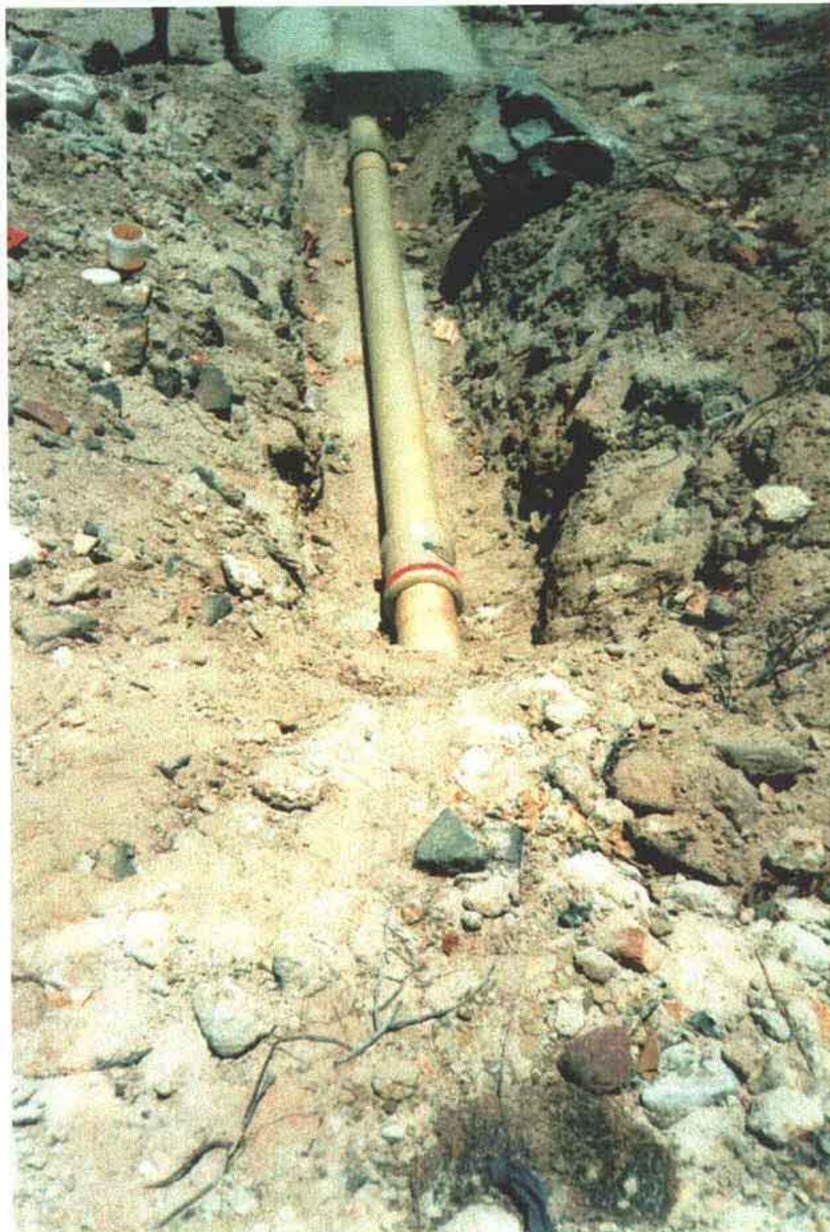
Foto 17 – Vista do tubo emendado.
