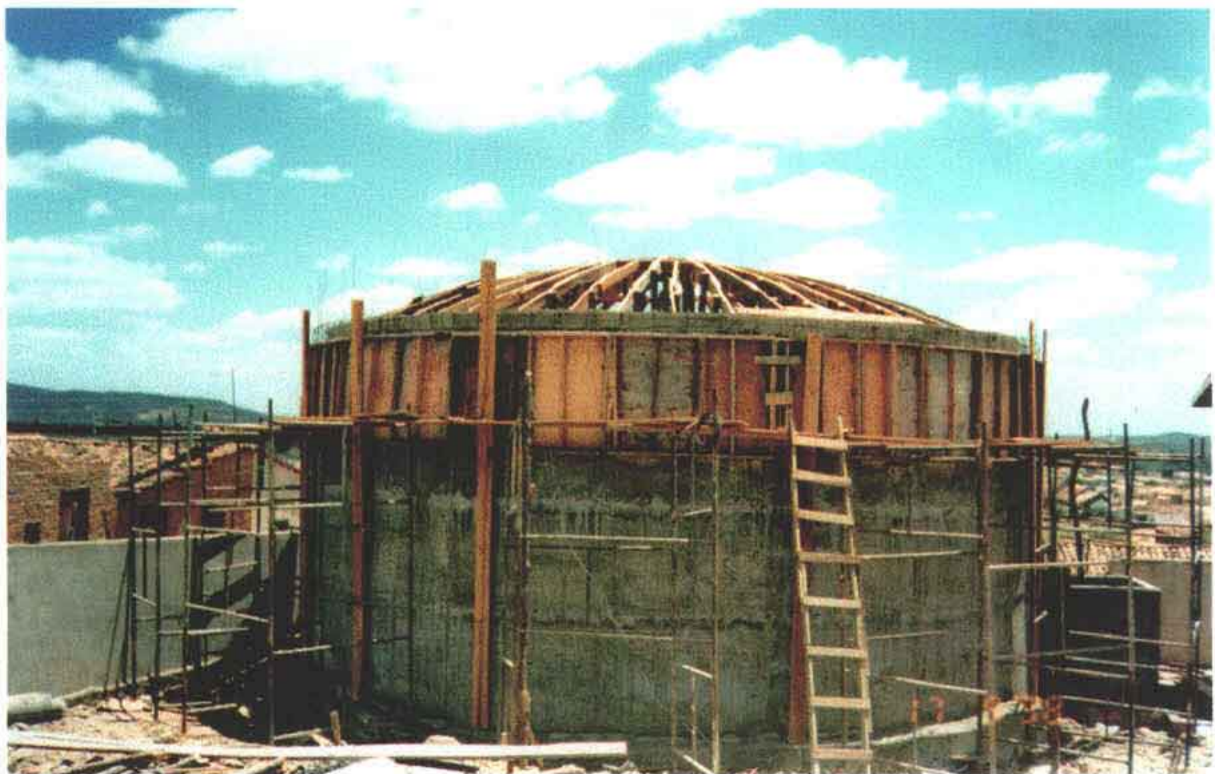
Foto 24 – Forma da tampa do reservatório apoiado de 200 m 3 .
