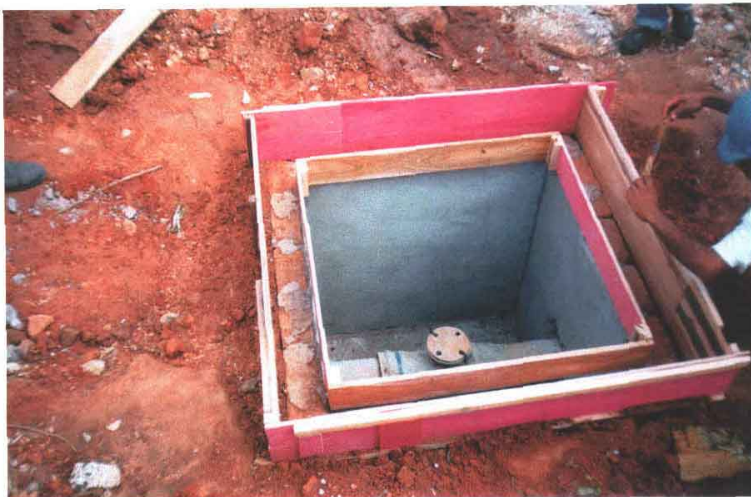
Foto 03 – Execução da caixa para ventosa em alvenaria de tijolo maciço, conforme padrão CAGECE.
