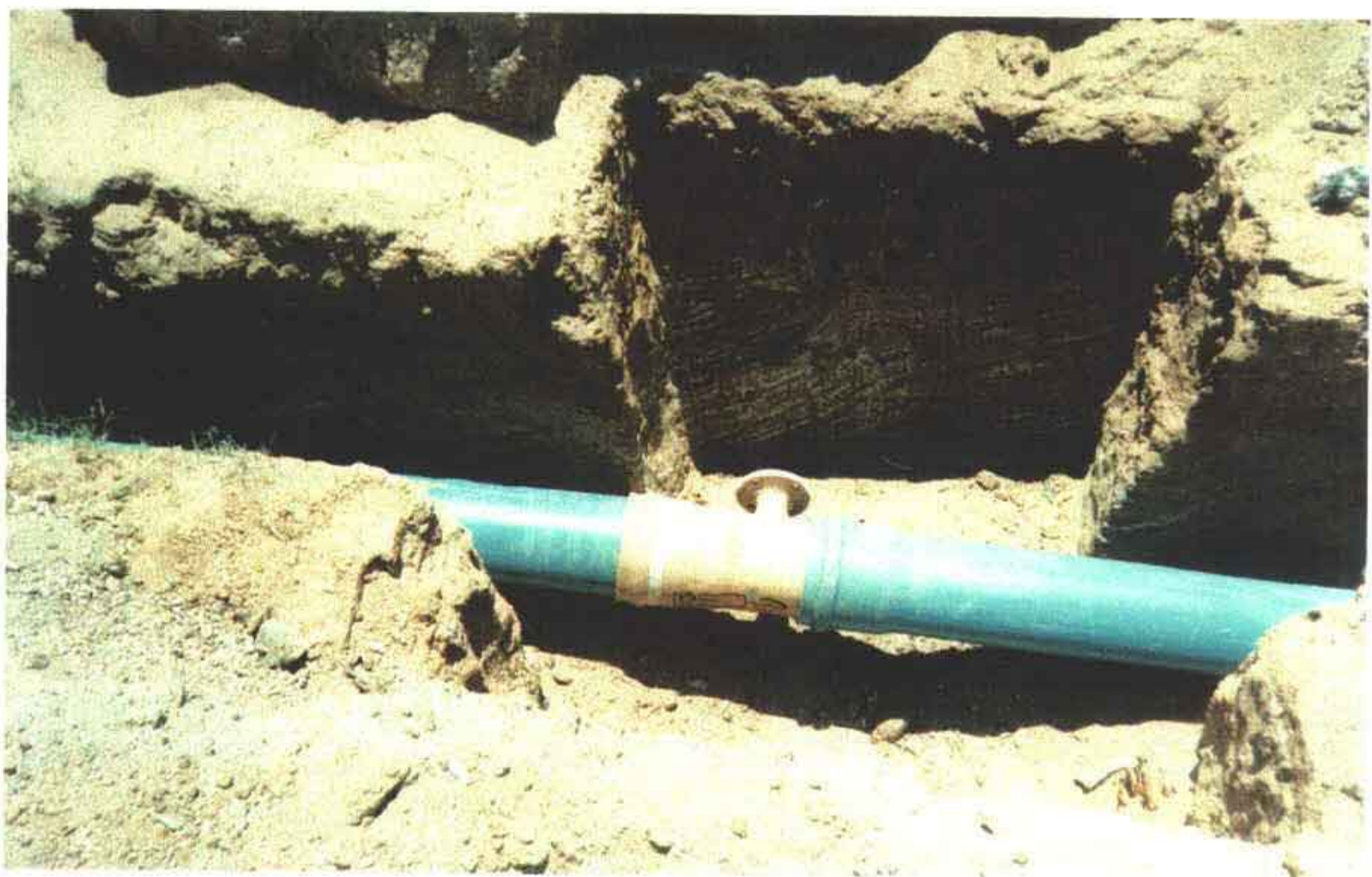
Foto 19 – Detalhe do início da escavação em rocha para caixa de registro de descarga.
