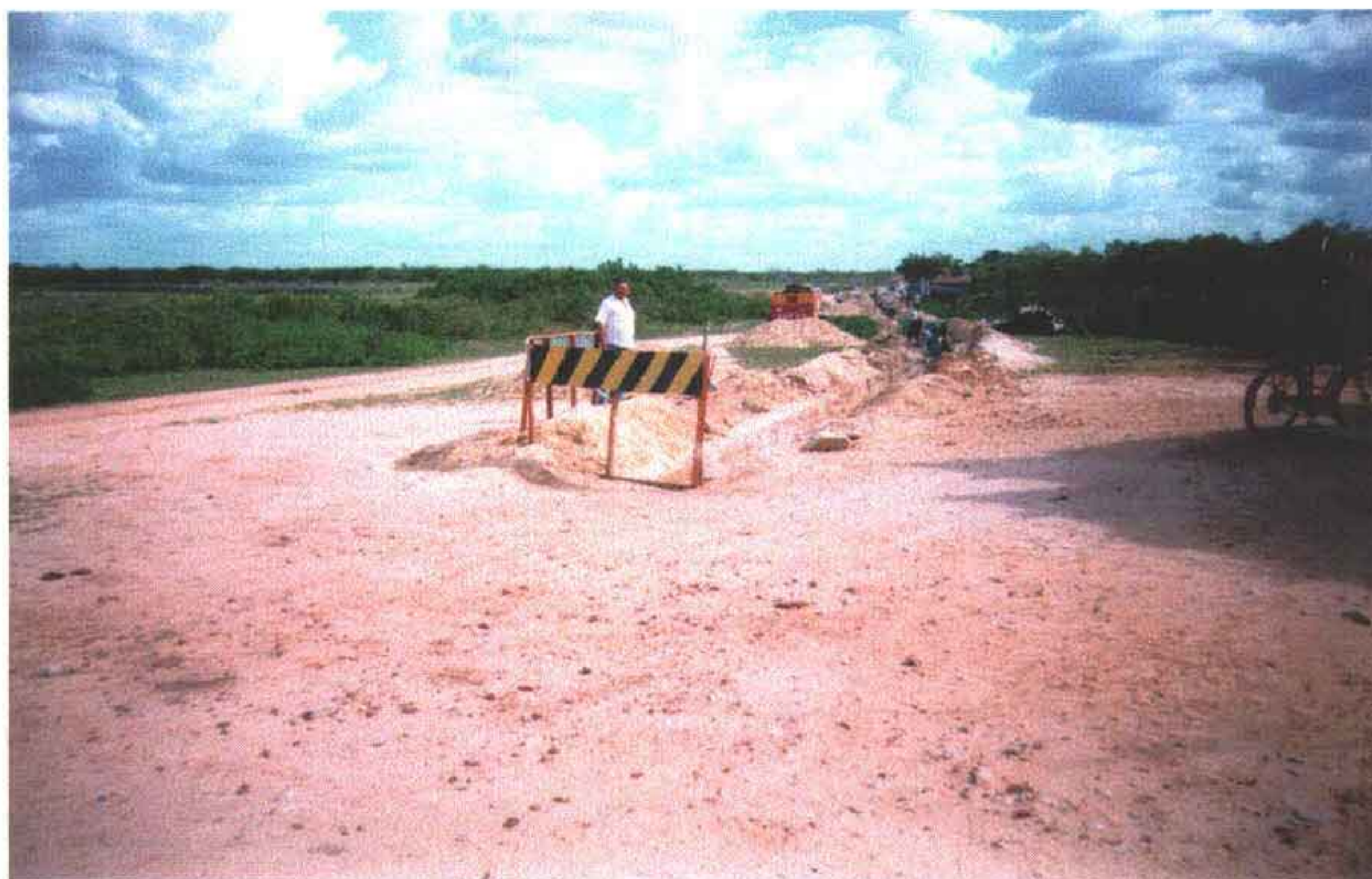
Foto 01 – Sinalização de barreira p/proteção de valas.
