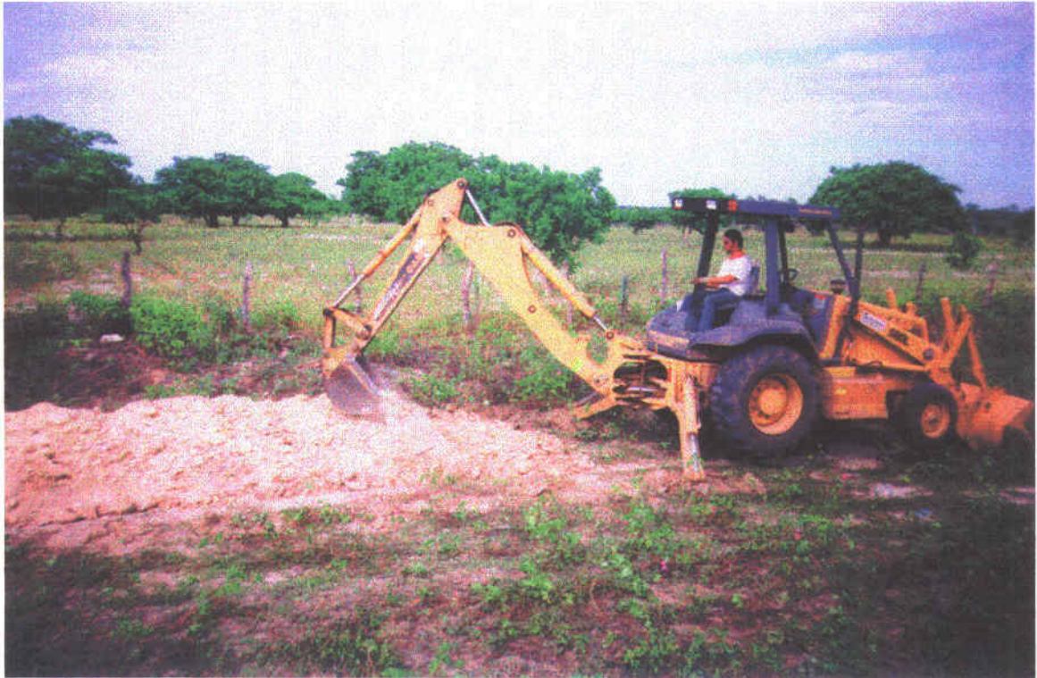
Foto 07 – Escavação de valas com retro-escavadeira.
