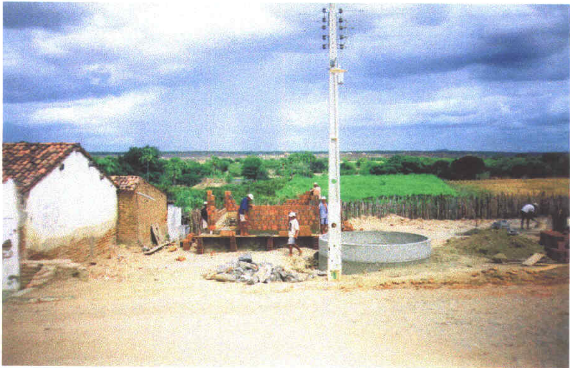
Foto 22 – Início da execução da casa de bomba da estação elevatória EE-1 e do reservatório elevado de 80 m 3 . Na ETA.
