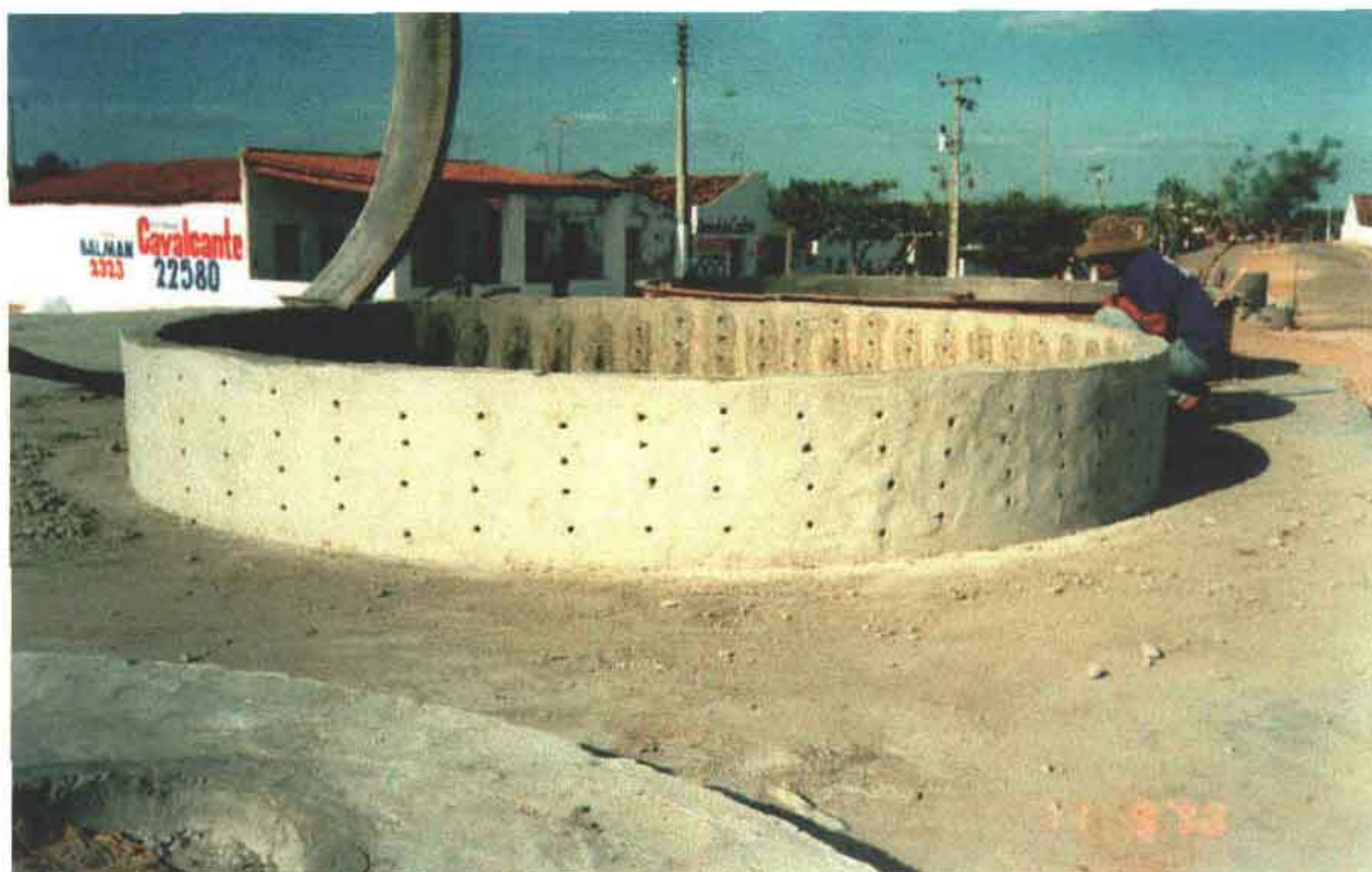
Foto 10 – Vista de um anel premoldado para execução do filtro do poço amazonas no Rio Banabuiú – Captação.
