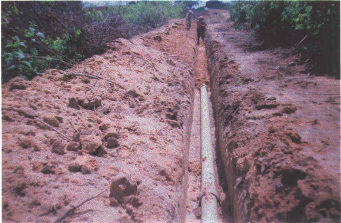
Foto 06 – Vala assentamento dos tubos RPVC e reaterro.
