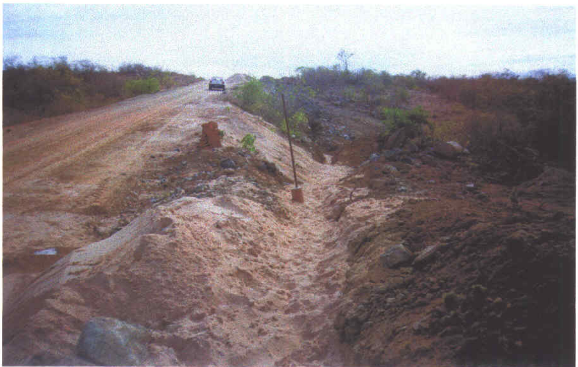
Foto 17 – Reaterro com material de primeira categoria transportado de outro local.
