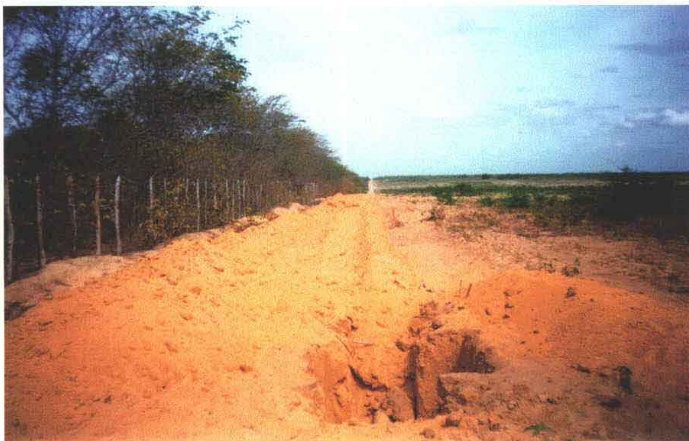
Foto 10 – Reaterro da vala e espalhamento de material.
