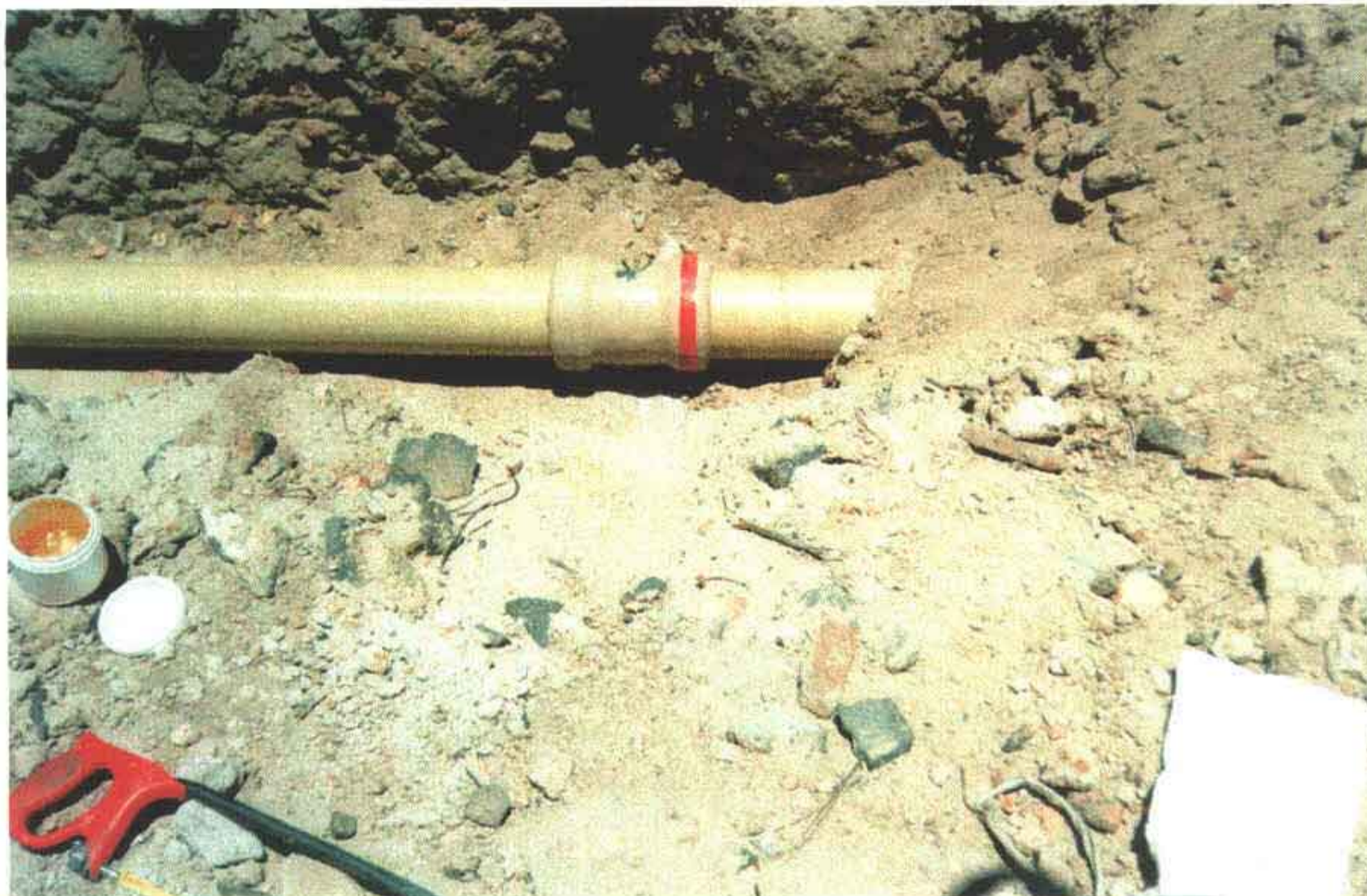
Foto 16 – Centralização da luva de união.
