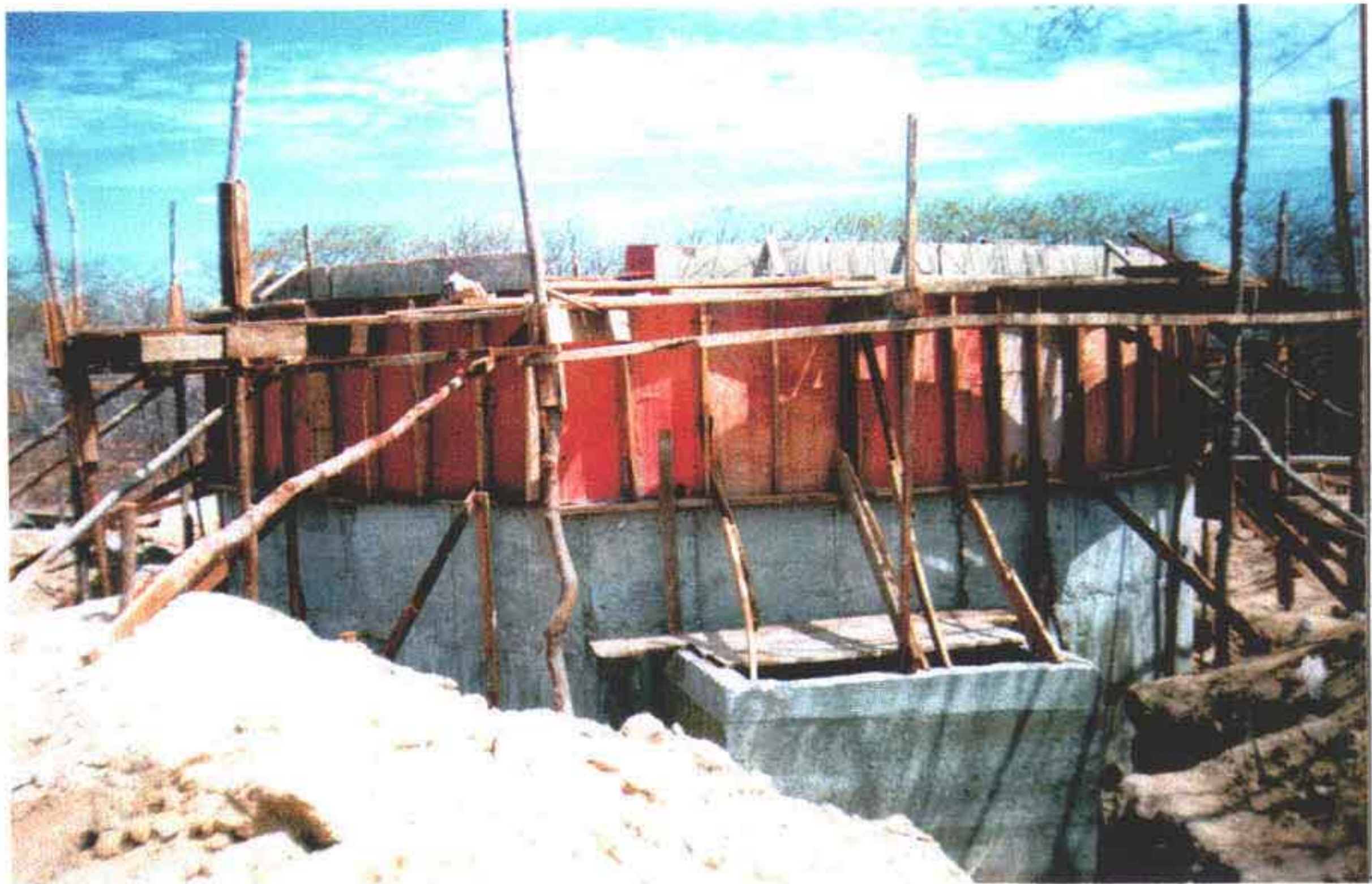
Foto 17 – Concretagem das paredes do reservatório apoiado de 100 m 3 na estaca 250.
