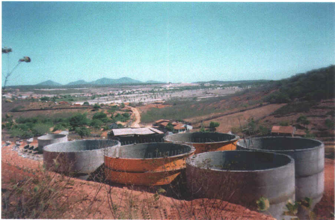
Foto 32 – Concretagem do reservatório apoiado de 300 m 3 .
