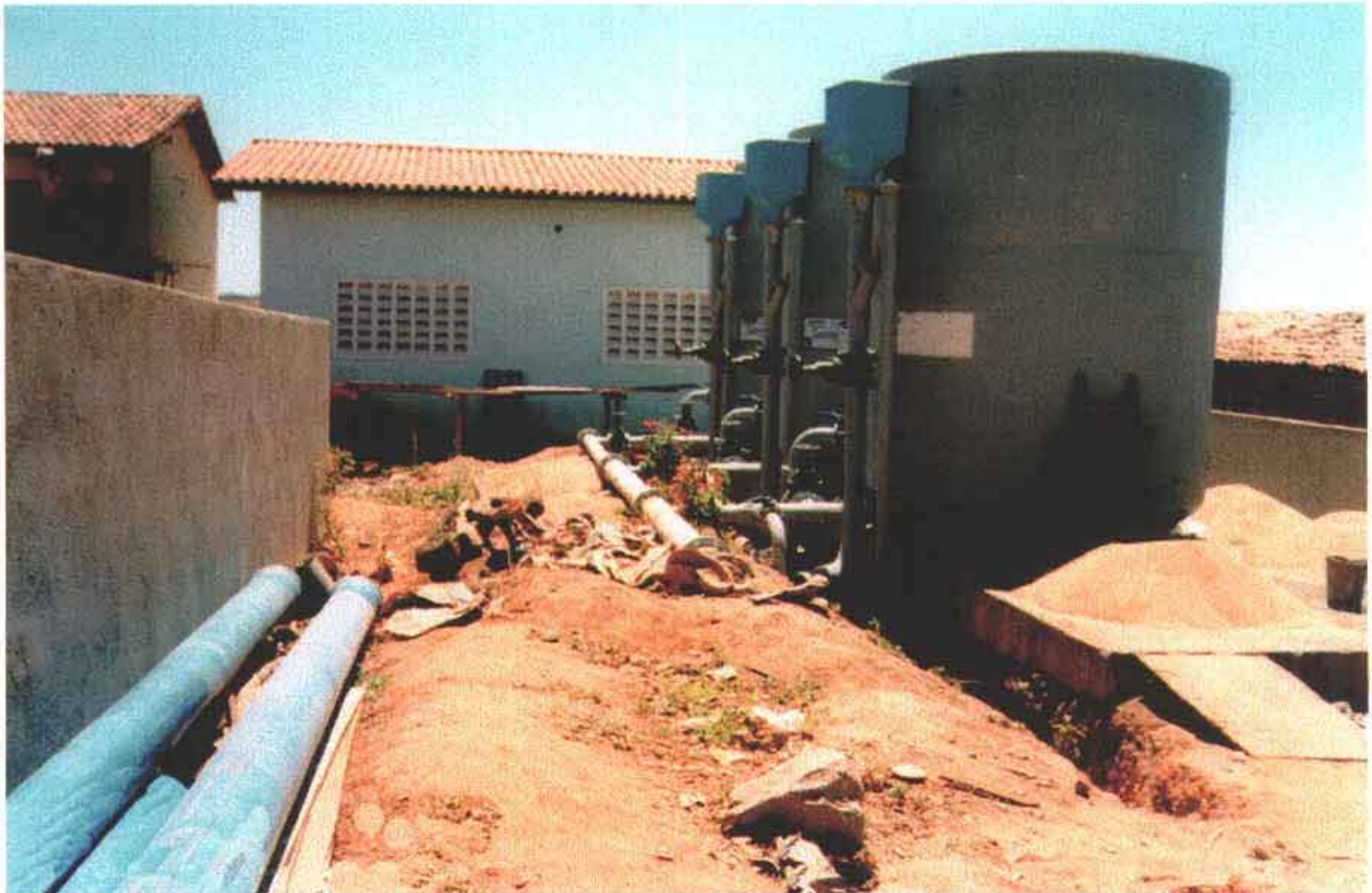
Foto 34 – Vista da casa de Química e filtros na ETA em fase de conclusão pela construtora responsável pelas obras da rede de distribuição.
