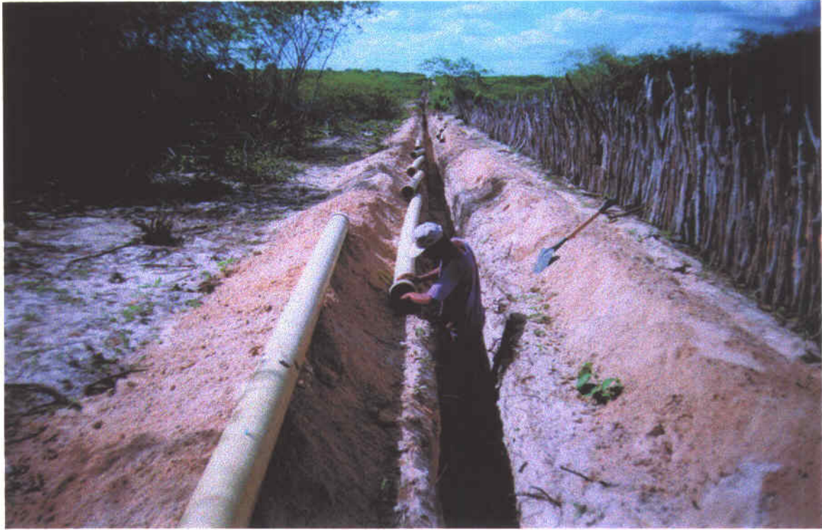
Foto 03 – Preparação dos tubos para serem assentados.
