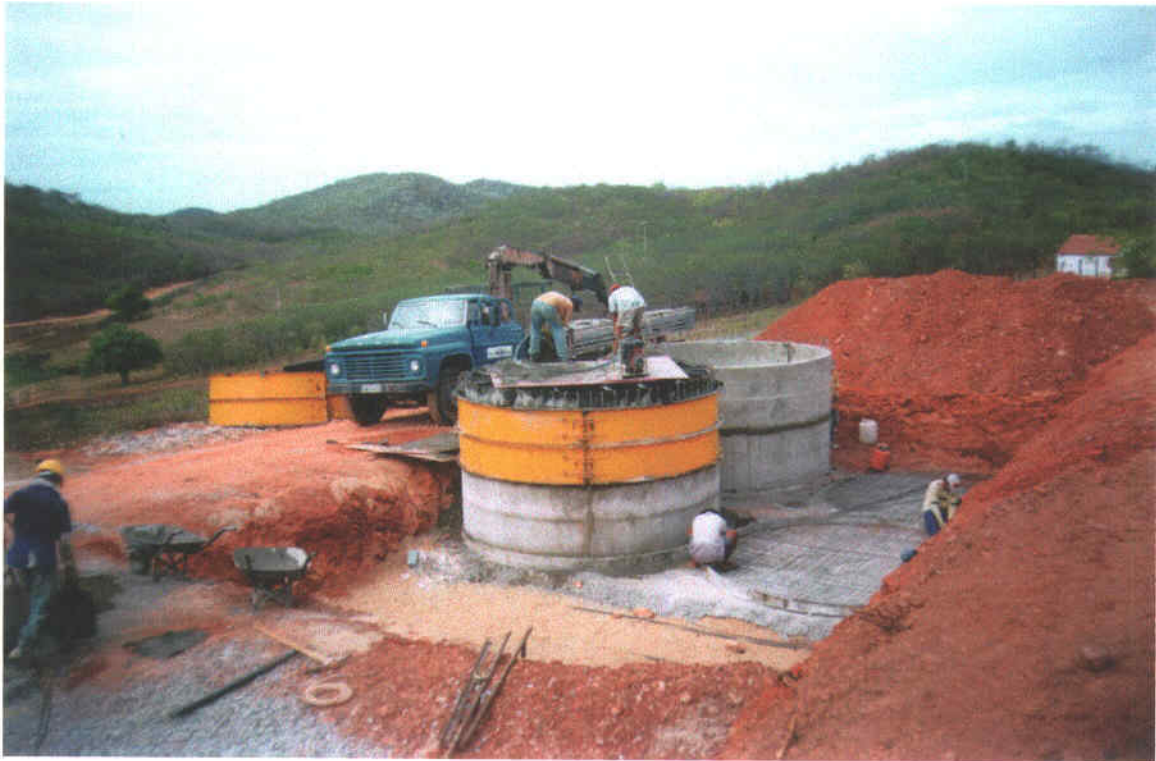
Foto 30 – Início da construção do reservatório apoiado de 300 m 3 .
