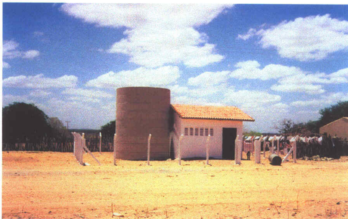
Foto 27 – Estação elevatória EE-2 – Casa de bombas e reservatório de 50 m 3 .
