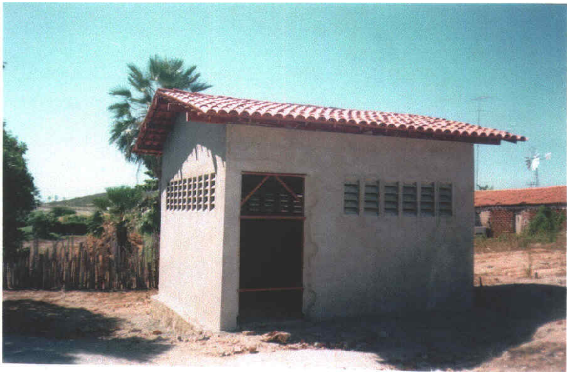
Foto 34 – Casa de bombas da estação elevatória EE-4.
